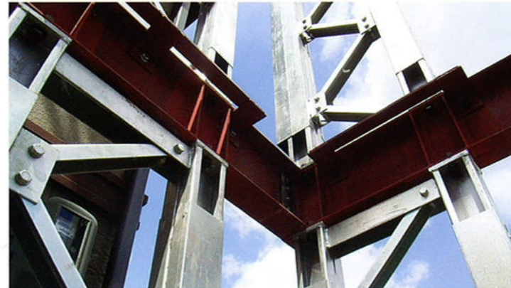
②トラス上部には250mm×100mmの溶接H形鋼を標準採用。壁構造でもバルコニーなどのハネ出しプランも可能です。
