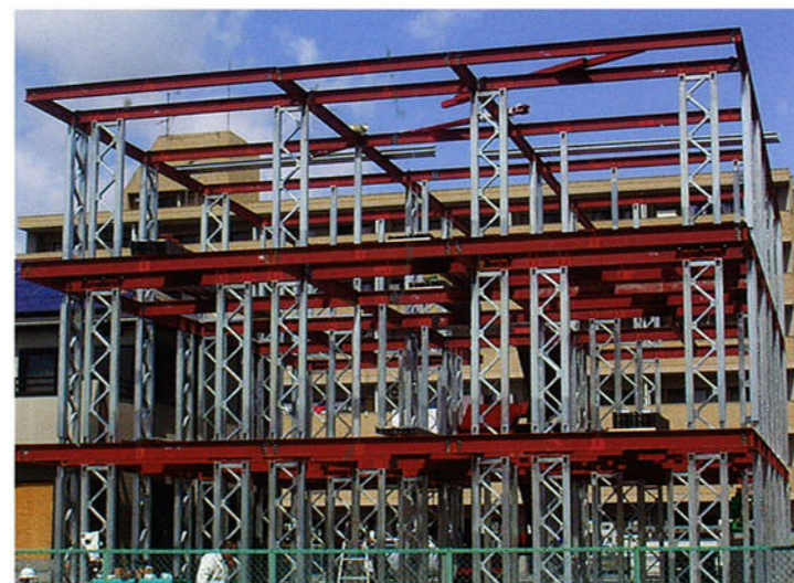
④防錆性能の高い溶融亜鉛メッキ鋼板を主要部材に採用。C形鋼の組み柱に、斜材をトラス構造に緊結させた耐力壁です。壁倍率は約30倍以上という高い耐震性を発揮します。
