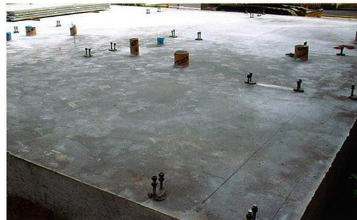
③構造計算により算出された基礎とトラスを特殊アンカーボルトにより緊結。地震や台風などに強い安心構造です。
