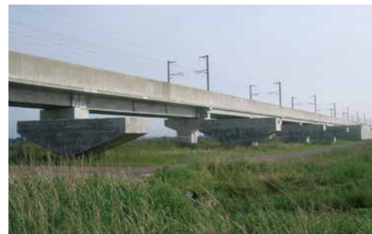
工事名：19国補道橋改 第19-03-845-0-003号 橋梁下部工事 ( (仮称) 谷口川橋梁) 発注者：茨城県つくばまづくりセンター 完成日：H20.7.31
