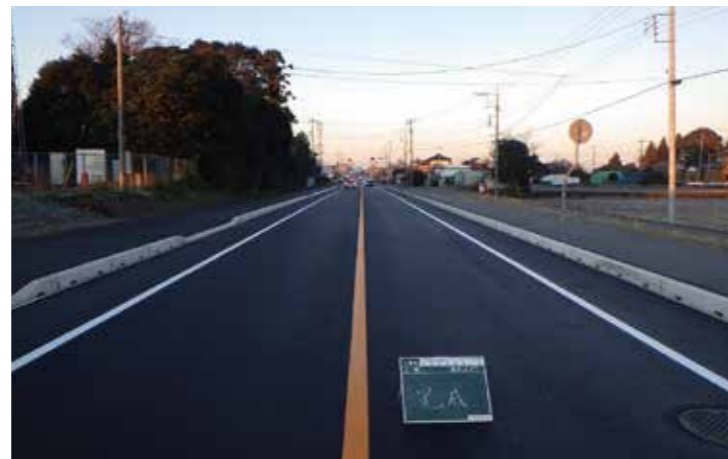
工事名：29国補地道 第29-03-162-0-002号 道路改良舗装工事 発注者：土浦土木事務所 完成日：H30.12.28
