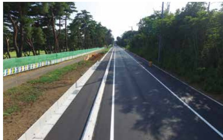
工事名：29国補地道 第29-03-707-0-002号 29新市づくり(住基) 第29-03-790-0-001号 合併 道路改良舗装工事(その1) 発注者：土浦土木事務所 完成日：H30.7.28
