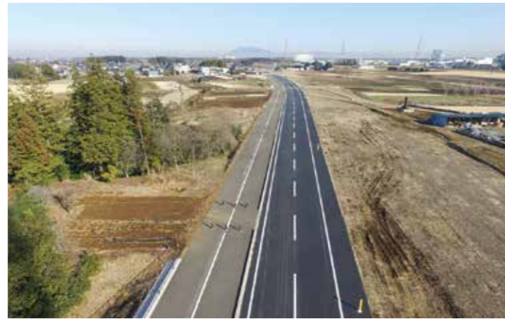
工事名：27県単支援助道改 第27-03-462-0-007号 道路舗装工事(その9) 発注者：土浦土木事務所 完成日：H29.1.21
