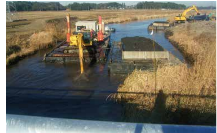
工事名：24国補河川総流防 第24-05-367-0-005号 河道掘削工事(その1) 発注者：土浦土木事務所 完成日：H25.2.20
