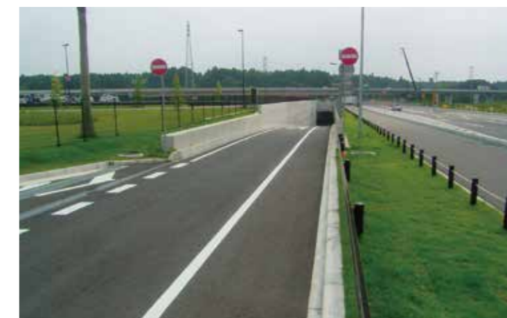
工事名：阿見まち交 第20-16-195-0-001号 町道6406号線 道路築造工事 (JV) 発注者：茨城県 完成日：H21.1.15
