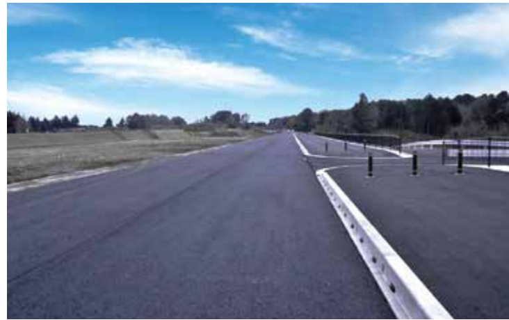
工事名：27県単支援助道改 第27-03-462-0-002号 26県単支援助道改 第26-03-462-0-006号 合併 道路舗装工事(その4) 発注者：土浦土木事務所 完成日：H28.3.15
