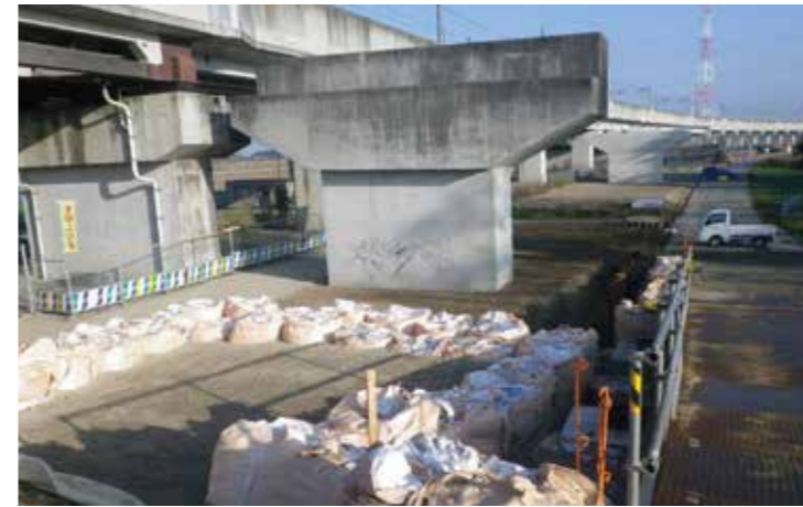
工事名：26国補地道 第26-03-180-0-002号 橋梁下部工事(その2) 発注者：土浦土木事務所 完成日：H28.1.27
