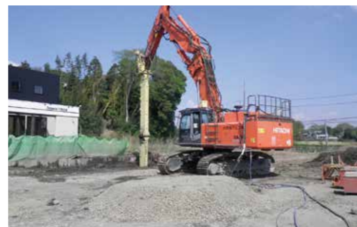
工事名：25県単支援道改 第25-03-462-0-004号 地盤改良工事(その7) 発注者：土浦土木事務所 完成日：H26.8.1
