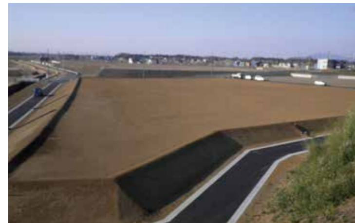
工事名：23国補街路 第23-16-162-0-005号 23国補公下 第23-09-090-0-008号 23国補公下 第23-09-090-0-009号 23県単地特 第23-16-098-0-012号 合併 宅地造成・道路改良舗装・下水道工事(337街区) 発注者：土浦土木事務所 完成日：H25.2.28
