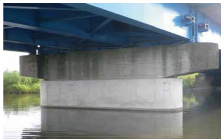
工事名：26国補地道 第26-04-194-0-001号 橋梁耐震補強工事(上岩崎橋) 発注者：土浦土木事務所 完成日：H27.7.31
