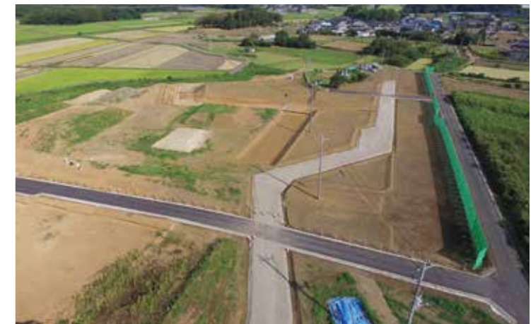
工事名：28国補緊道 第28-16-213-0-008号 宅地造成工事(A街区北) 発注者：土浦土木事務所 完成日：H29.9.14
