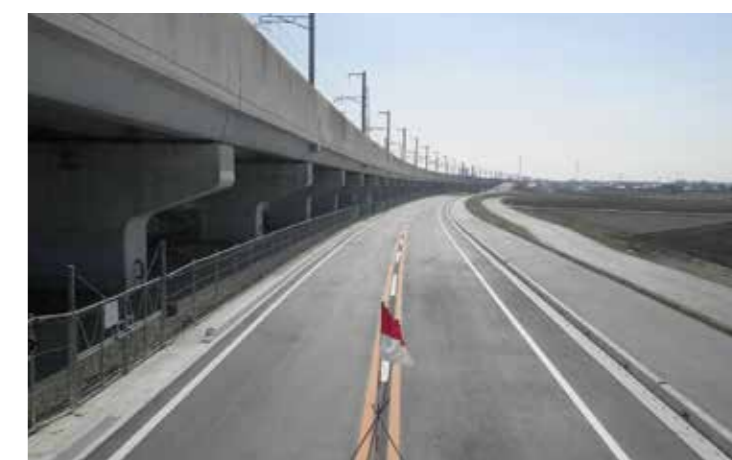
工事名：24国補地道 第24-03-180-0-002号 道路改良舗装工事 発注者：土浦土木事務所 完成日：H25.3.15
