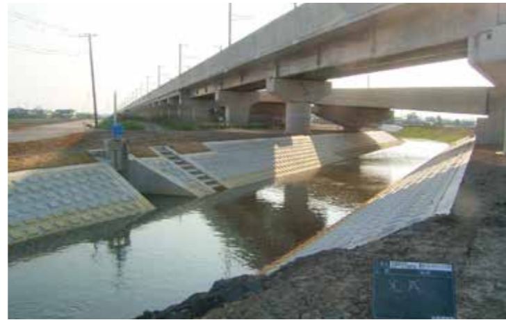
工事名：25国補地道 第25-03-180-0-003号 25国補河川総流防 第25-05-925-0-001号 合併 河川付替工事(その1) 発注者：土浦土木事務所 完成日：H26.6.14
