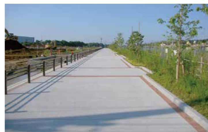
工事名：20国補街路 第20-16-039-0-012号 20県単公下 第20-09-090-0-031号 合併 道路改良舗装工事 発注者：茨城県つくばまちづくりセンター 完成日：H21.8.31
