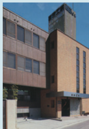
神戸支店ビル
