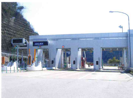
東海北陸自動車道IC料金所連絡通路
