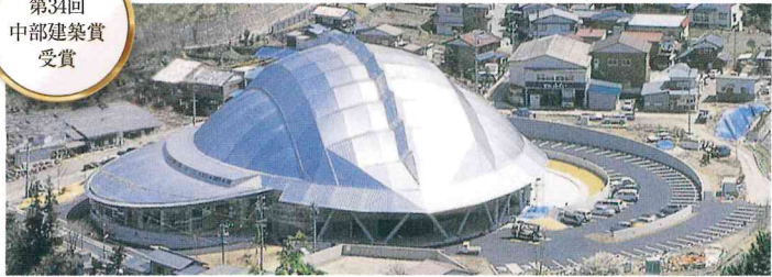
郡上八幡総合スポーツセンター
