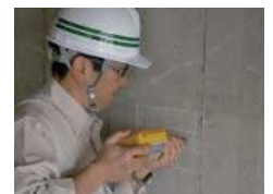
コンクリート強度検査
