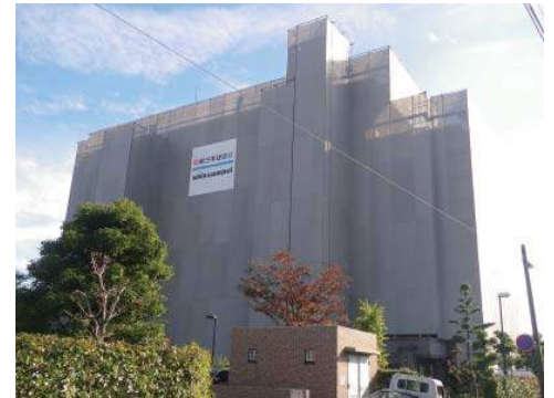
大規模修繕・外部足場設置
