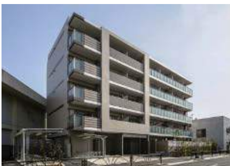
メティス K II (H27 年竣工 / 東京都葛飾区)
