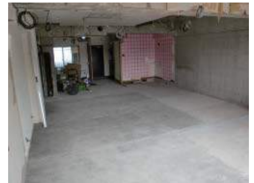
マンション一室を解体、スケルトン状態
