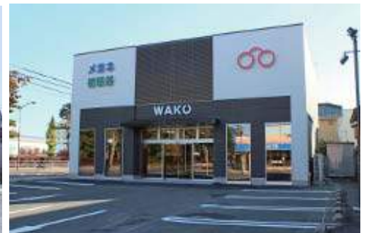
和光メガネ (H28 年竣工 / 栃木県下野市)
