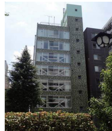
Tビル (鉄骨ブレース)
