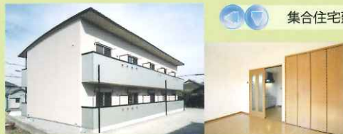
戸建住宅建築工事
