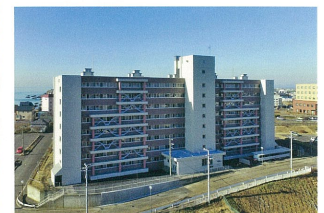
■柏木公営住宅KI耐震改修 (2016年)
