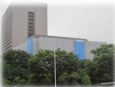
宮城県庁舎ほか災害復旧工事
