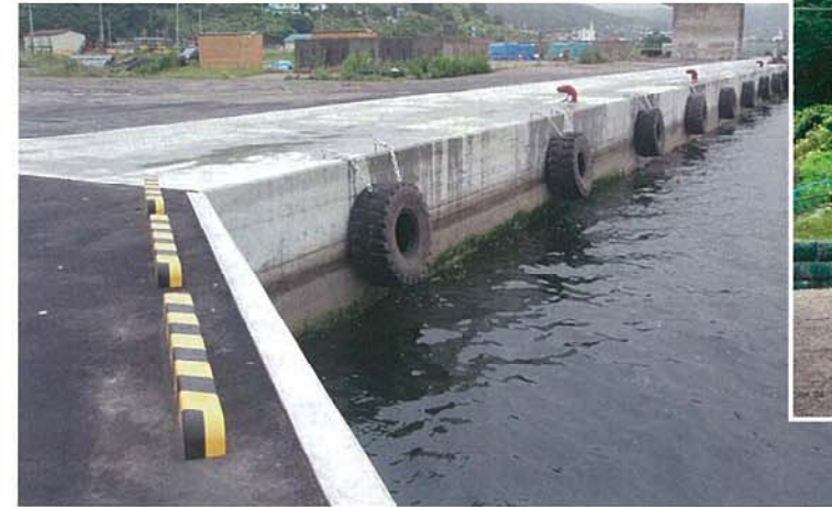
岸壁改修工事
