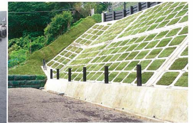
急傾斜地工事
