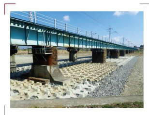
矢板・野崎間笹川橋りょう洗掘対策 施工場所：大田原市 発注者：東鉄工業(株) 竣工年：2020年
