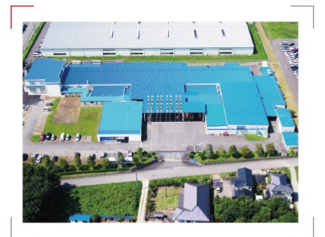
パナソニックスイッチングテクノロジーズ 大田原事業場 施工場所：大田原市 発注者：パナソニック スwitchングテクノロジーズ(株) 竣工年：2020年
