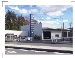
大島自販BPセンター 施工場所：那須塩原市 発注者：(株)大島自販 竣工年：2015年
