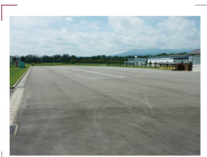
パナソニック スイッチングテクノロジーズ 駐車場
