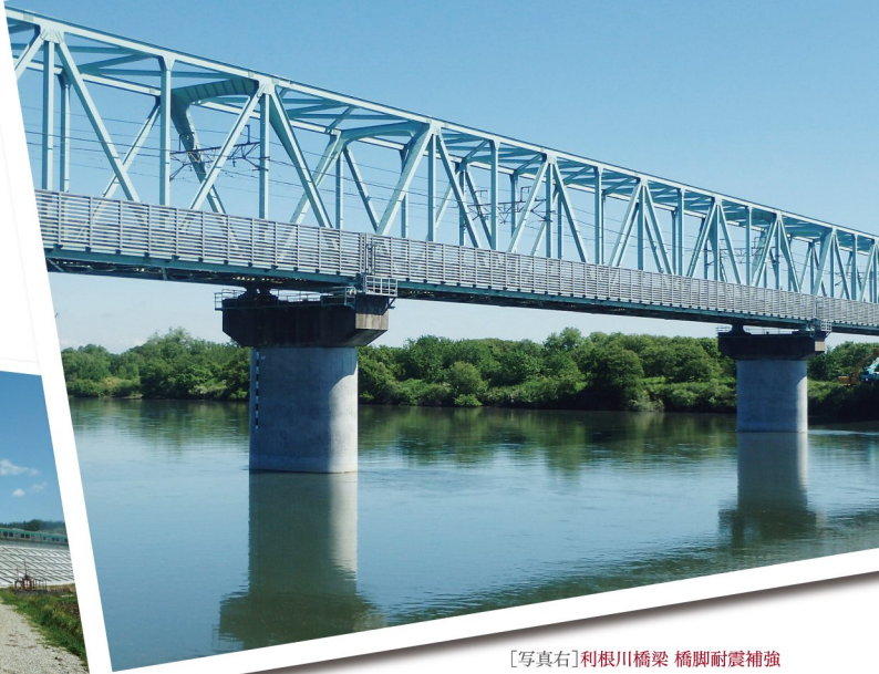
[写真右]利根川橋梁 橋脚耐震補強 施工場所：茨城県古河市 発注者：東鉄工業(株) 竣工年：2016年
