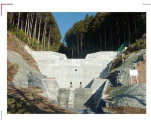
砂防堰堤 上大輪沢
