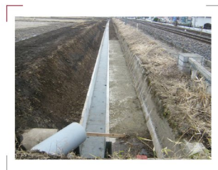
高久・黒田原間 農業用排水 施工場所：那須郡那須町 発注者：(株)交通建設 竣工年：2016年
