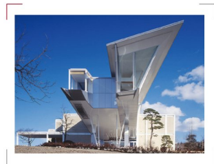
旧大田原市立両郷中学校 施工場所：大田原市 発注者：黒羽町 竣工年：1998年
