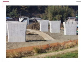
北関東自動車道田島高架橋(下部工) (JV 施工)
