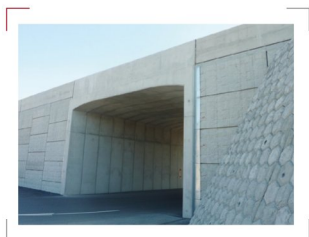
一般国道408号真岡宇都宮バイパス (JV 施工)
