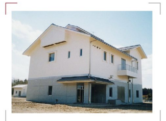
大田原市黒羽水処理センター(JV施工) 施工場所：大田原市 発注者：日本下水道事業団 竣工年：1999年
