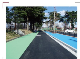
美原公園外周路舗装
