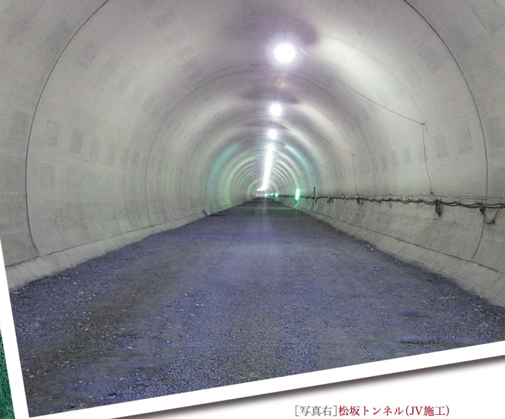
[写真右] 松坂トンネル (JV 施工)
