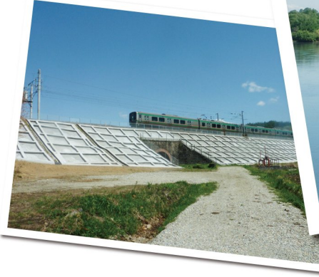
[写真左]東北線 豊原法面保護 施工場所：那須郡那須町 発注者：(株)交通建設 竣工年：2017年
