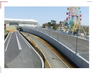
総合スポーツゾーン連絡通路整備
