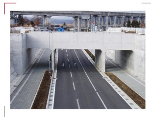
東北線 新白河・白河間米村跨道橋 施工場所：福島県白河市 発注者：鉄建建設(株) 竣工年：2003年
