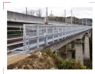
黒磯・高久間那珂川橋りょう転落防止柵 施工場所：那須郡那須町 発注者：(株)交通建設 竣工年：2020年
