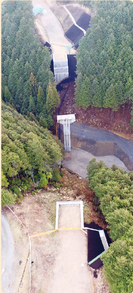
◆土木事業【道路改良工事】丸山ダム
