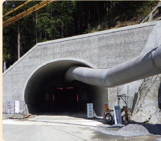
◆土木事業【山岳トンネル】(下呂市内)
