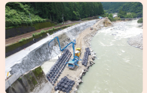
◆豪雨災害による復旧(小坂町門坂地区)
