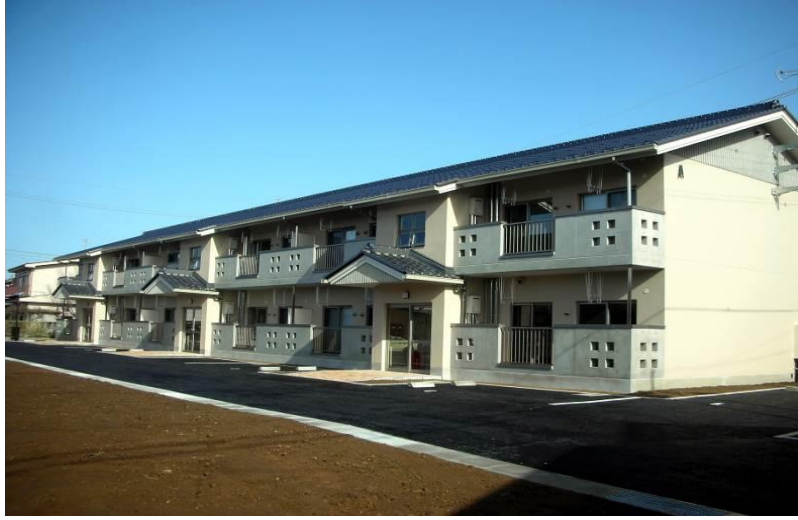
地域住宅交付金 公営住宅整備事業相生団地他建替工事 〔構造〕鉄筋コンクリート造 2階建 〔規模〕延床面積 767㎡
