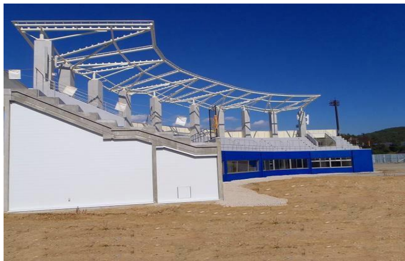
総合運動公園 野球場 メインスタンド建築工事 〔構造〕鉄筋コンクリート2階建 〔規模〕延面積 922.03㎡
