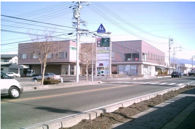
家具のコヤマ新築工事 〔構造〕鉄骨造 2階建
