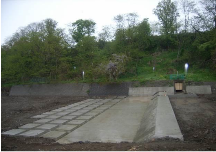
台風9号災害復旧事業頭首工復旧工事
