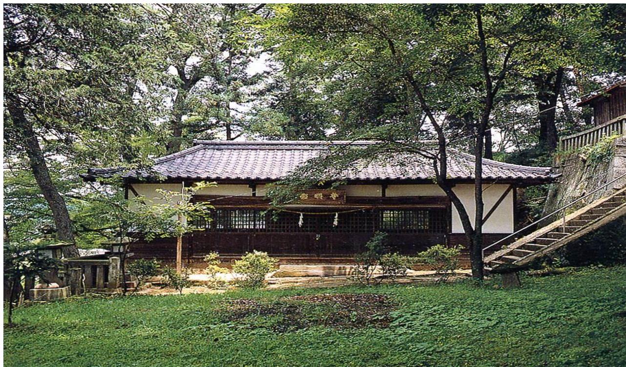
平賀神社豊明殿改築工事 〔構造〕木造 平家建
