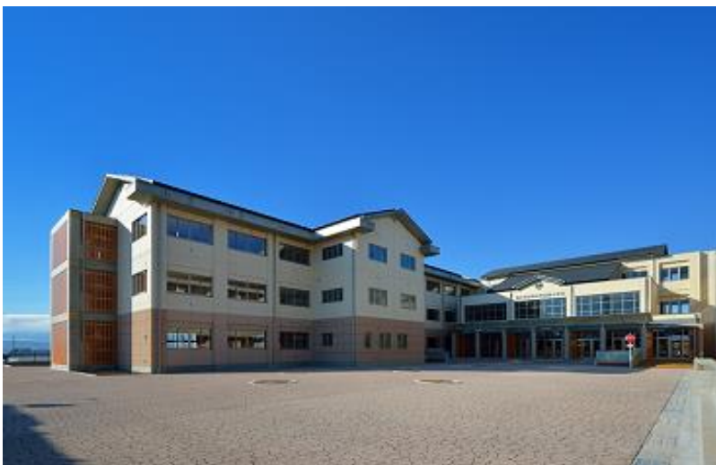
佐久平浅間小学校昇降口棟及校舎棟
