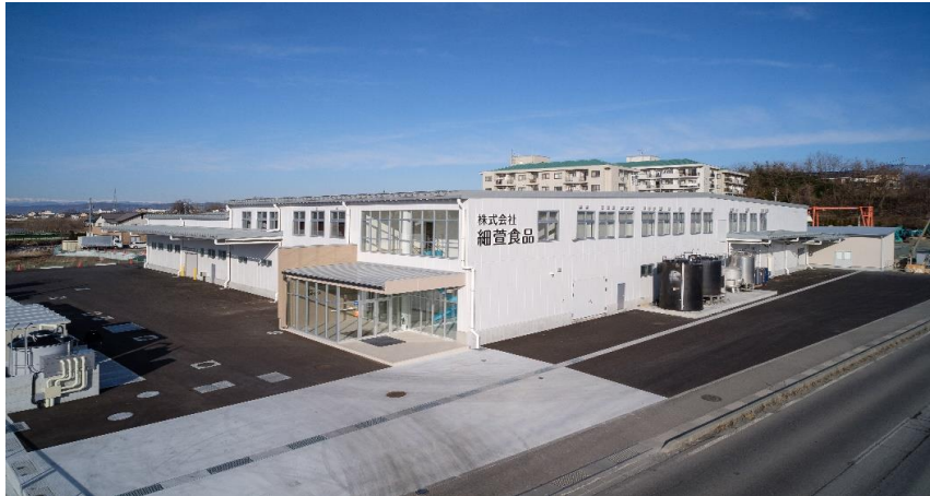
株式会社 細萱食品工場新築工事 〔構造〕鉄骨造 2階建 〔規模〕延面積 4,811.8㎡
