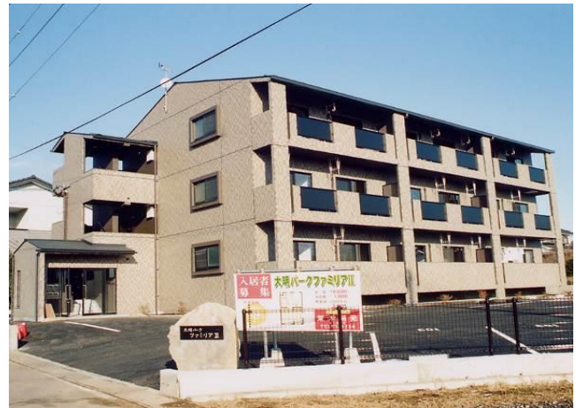
H様賃貸マンション新築工事 〔構造〕鉄筋コンクリート造3階建
