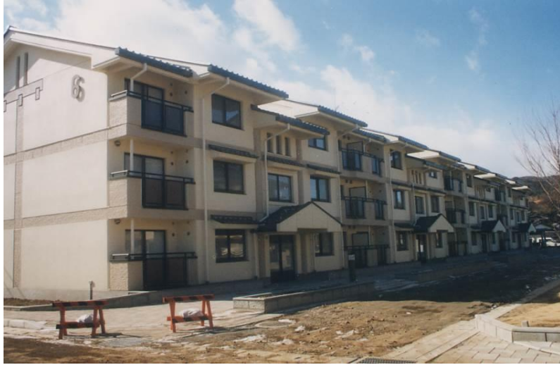
県営住宅泉団地6号棟建築工事 〔構造〕鉄筋コンクリート造 3階建
