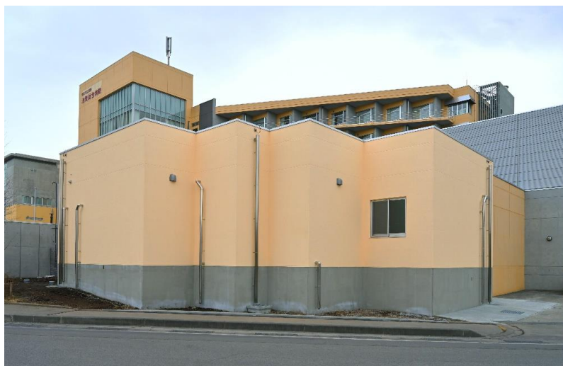
佐久市立国保浅間総合病院 循環器内科血管造影室増設工事 〔構造〕鉄筋コンクリート造 〔規模〕延面積 184.08㎡
