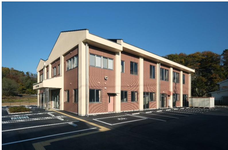
佐久市東会館改築(本体)工事 〔構造〕鉄筋コンクリート造 〔規模〕延面積 1,061㎡
