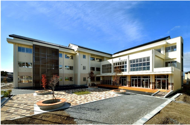
佐久市立岩村田小学校 普通特別教室棟改築(本体)工事 〔構造〕鉄筋コンクリート3階建 〔規模〕延面積 5,384㎡
