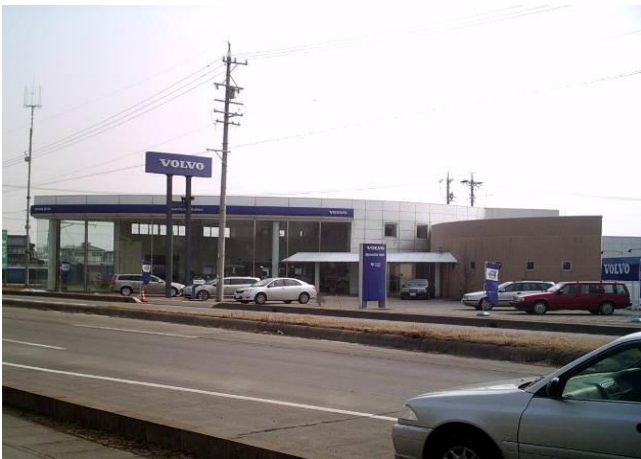
ヨコタ・インターナショナル西軽井沢店新築工 〔構造〕鉄骨造 2階建
