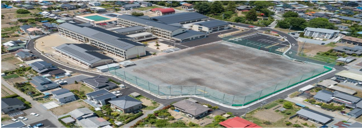
佐久市立岩村田小学校グラウンド整備工事
