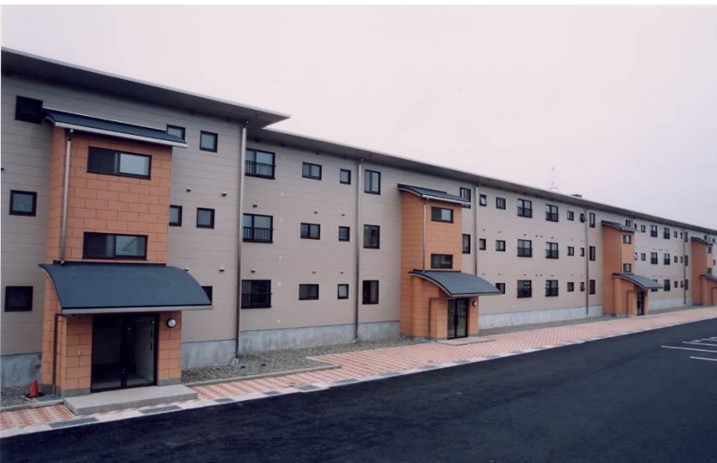
警察官待機宿舎新築(佐久地区) 建築主体工事 〔所在地〕佐久市 〔構造〕鉄筋コンクリート造 3階建
