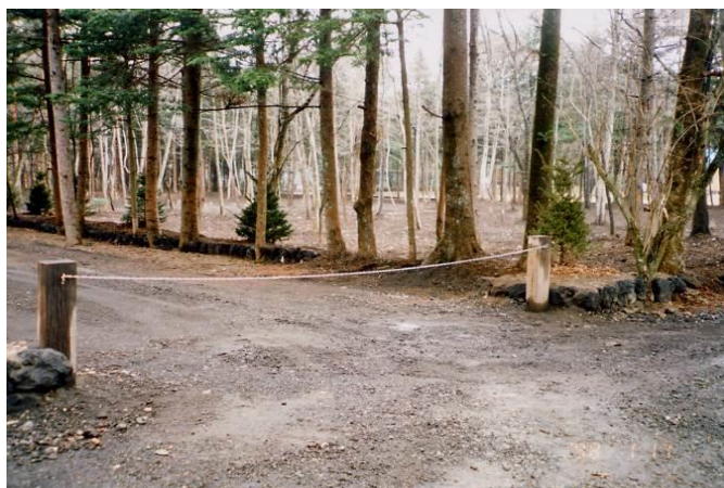
軽井沢南ヶ丘分譲地造成工事 〔規模〕12区画
