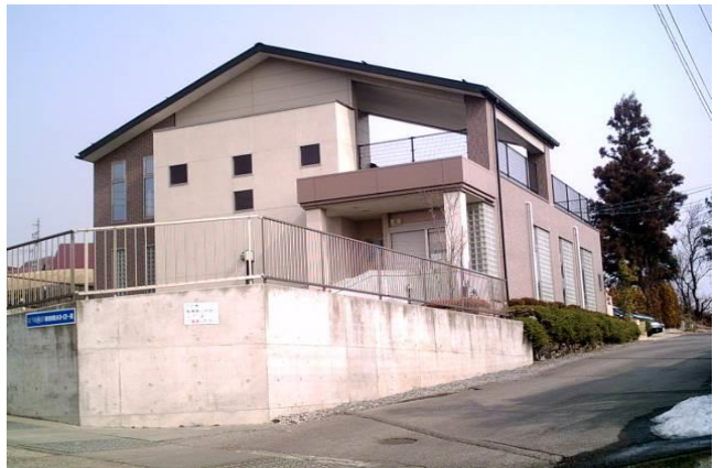
Y動物病院新築工事 〔構造〕鉄骨造 2階建 〔規模〕延面積 297.11㎡
