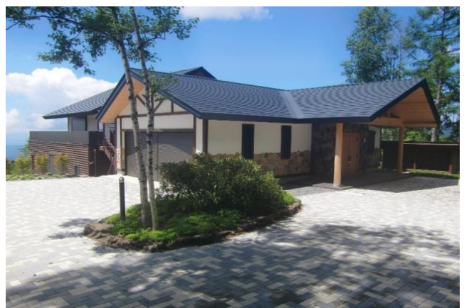
A様山荘新築工事 〔構造〕木造 2階建
