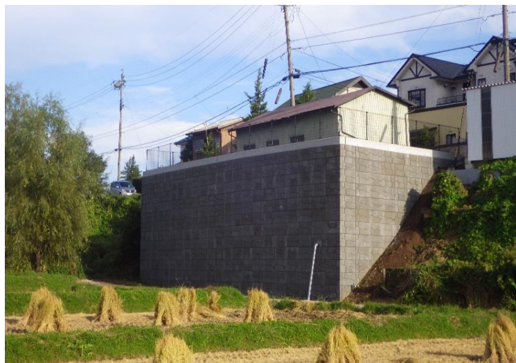
K様邸擁壁改修工事
