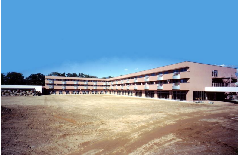
有料老人ホーム 「萬里の郷」新築工事 〔構造〕鉄骨造 3階建
