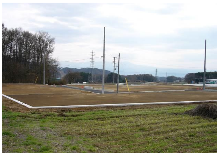
御代田町大塚宅地造成工事 〔規模〕9区画
