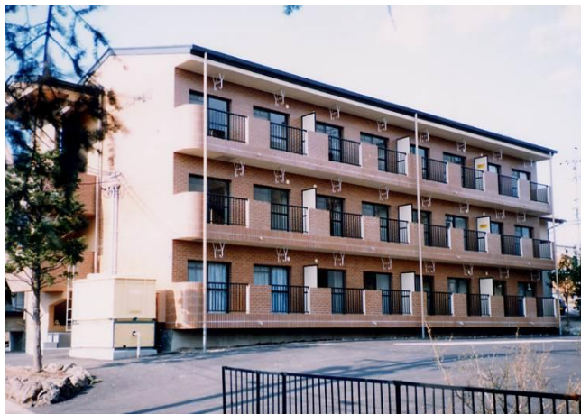
Y様マンション新築工事 〔構造〕鉄筋コンクリート造3階建
