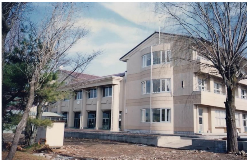
佐久市立中込中学校管理棟新築工事 〔構造〕鉄筋コンクリート造 3階建
