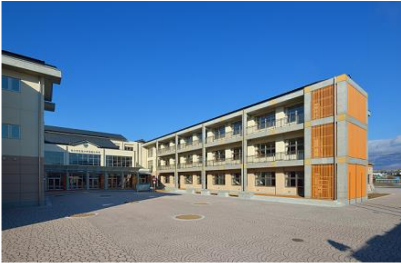
佐久平浅間小学校校舎棟新築工事 〔構造〕鉄筋コンクリート造 3階建 〔規模〕延面積 8140.73㎡
