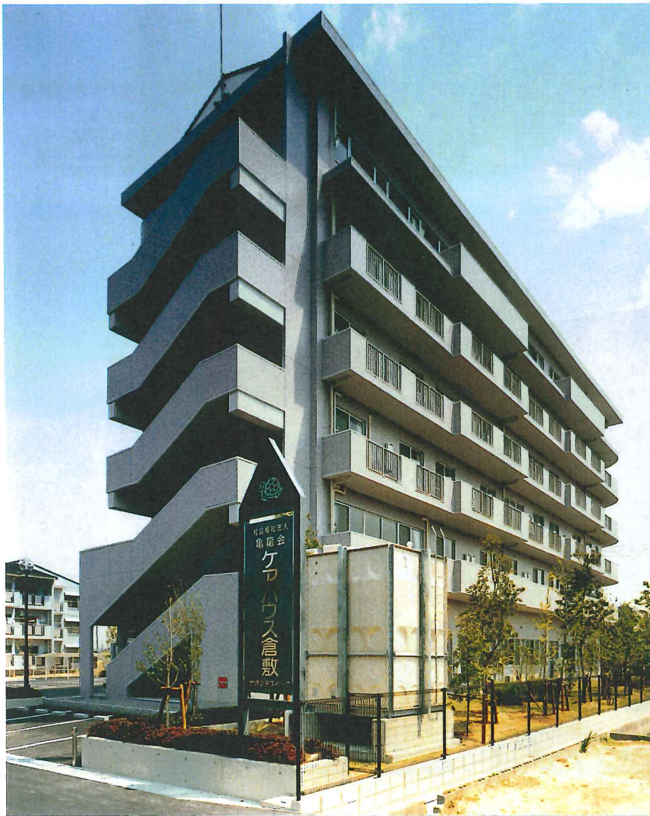
■ケアハウス倉敷(社会福祉法人 亀龍会)様 設計・施工/RC造6階建/延床面積:3,522㎡/倉敷市亀山
