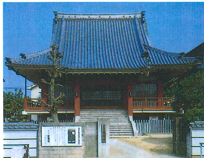
■定福寺様 本堂 設計・施工/RC造2階建/延床面積:315㎡/福山市西町三丁目
