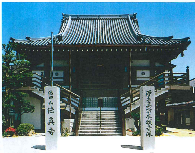
■法真寺様 設計・施工/RC造2階建/延床面積:579㎡/福山市吉津町
