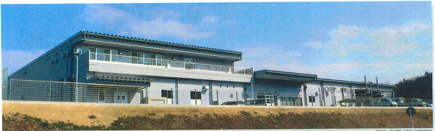
■(株)朋昆様 施工/S造2階建/延床面積:6,293㎡/尾道市美郷町
