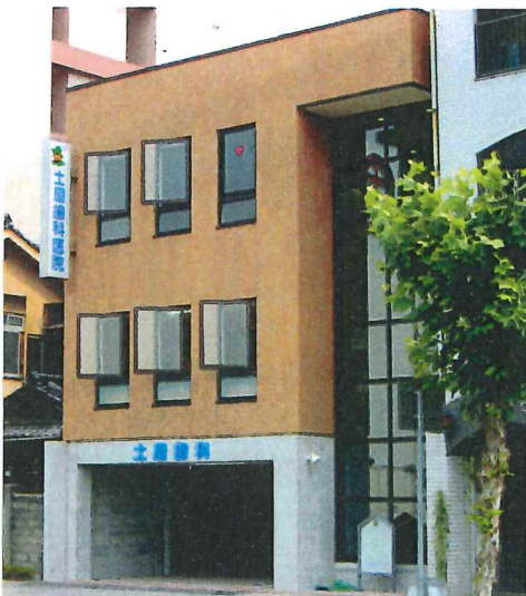
■ 土 屋 歯 科 医 院 様 設計・施工/S造3階建/延床面積:543㎡/福山市御船町一丁目
