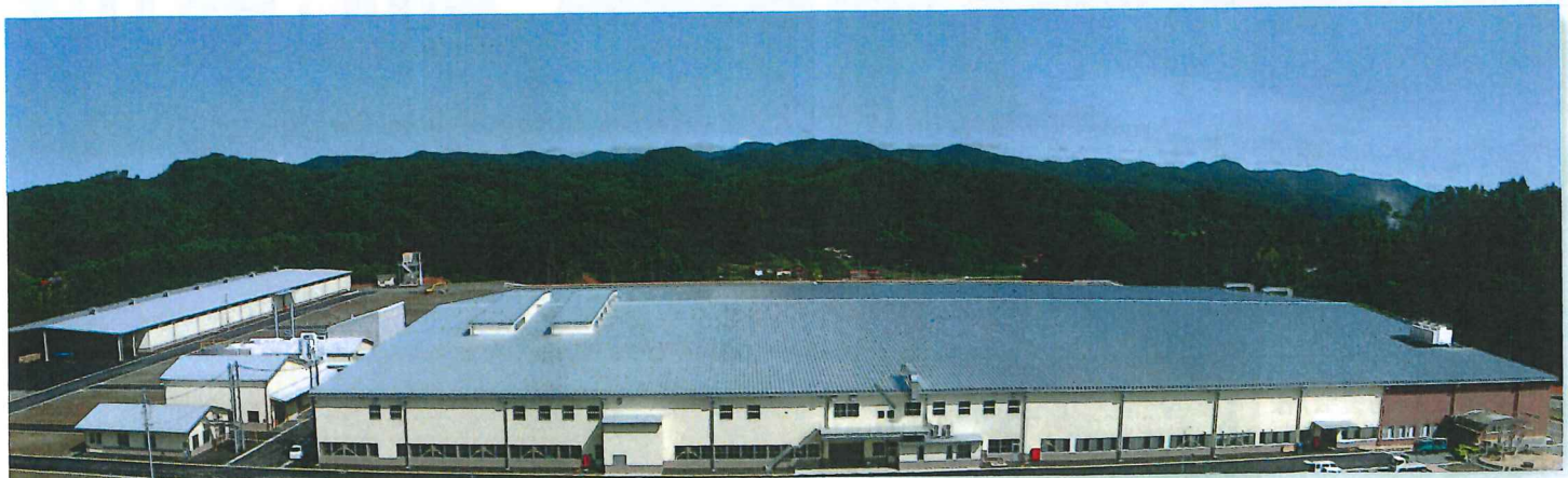
■カイハラ産業(株)様 三和工場 設計・施工/S造2階建/延床面積:26,121㎡/神石高原町上
