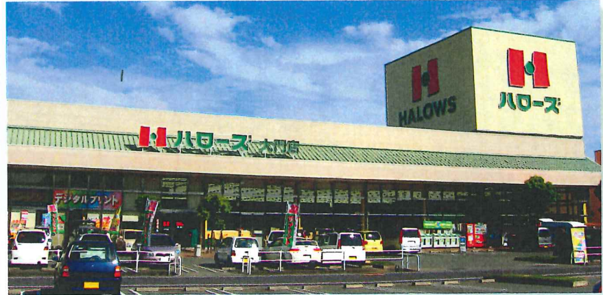
■ハローズ様 大前店 《設計・監理》三谷豊建築設計室 施工/S造1階建/延床面積:2,858㎡/福山市大前町二丁目
