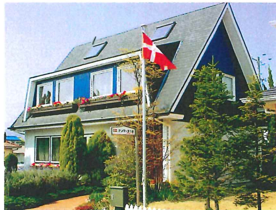
スカンジナビアハウス施工事例の一部です。
