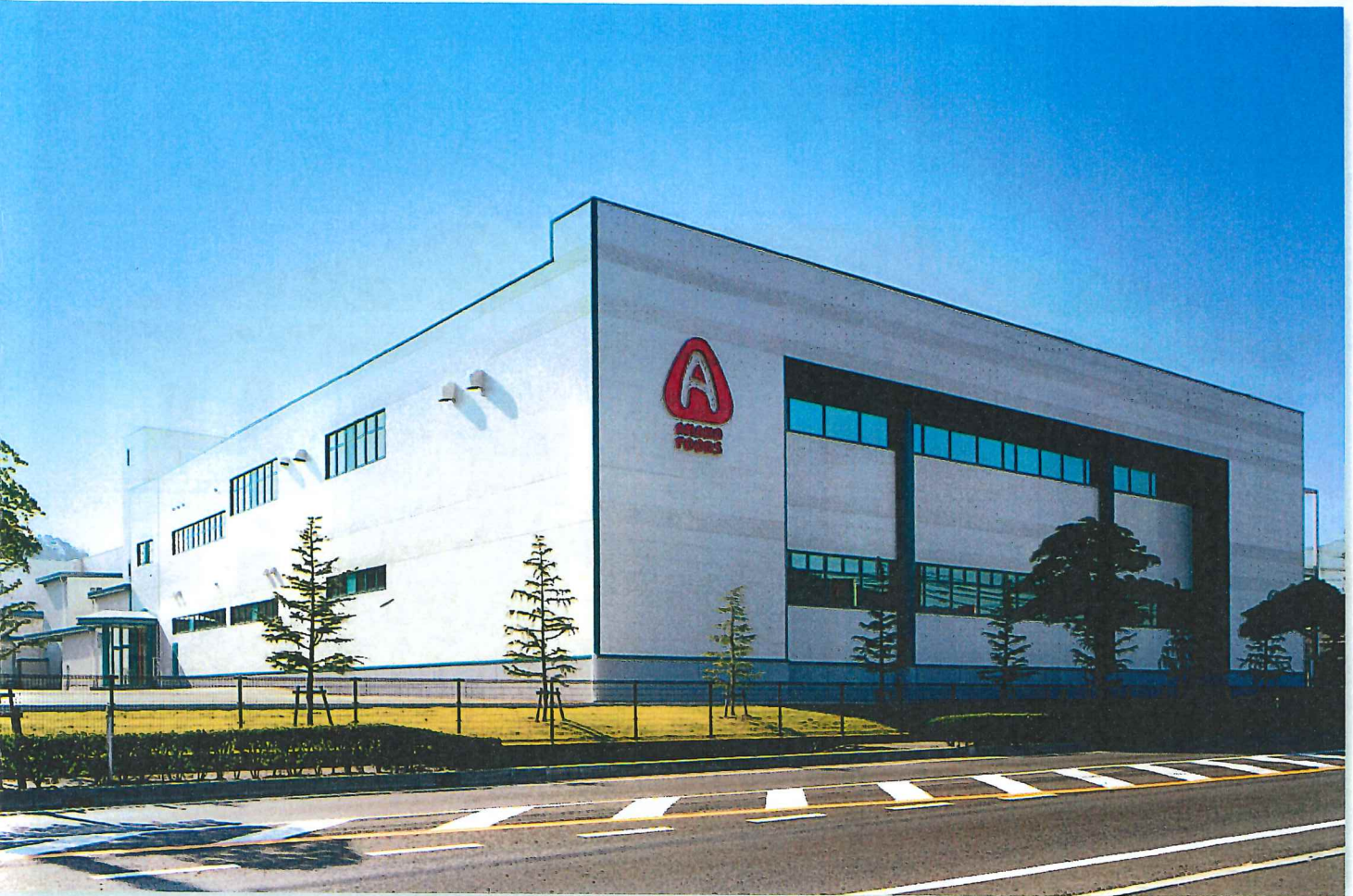
■天野実業(株)様 里庄第2工場 施工/S造2階建/延床面積:4,800㎡/里庄町里見
