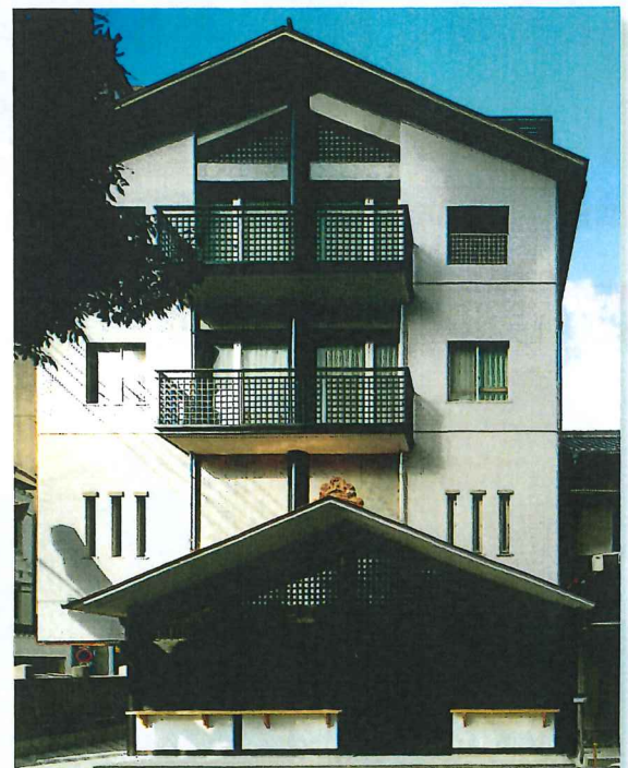
■出雲大社様 岡山分祠 《設計・監理》(株)馬庭建築設計事務所 施工/RC造4階建/延床面積:434㎡/岡山市中山下
