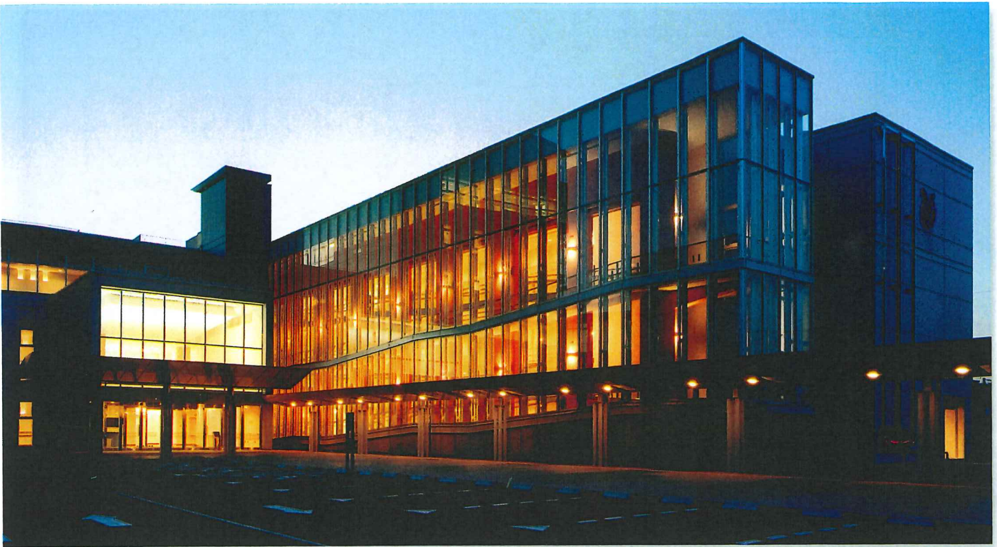
■ 福山すこやかセンター 施工JV/SRC造地下1階、地上6階建/延床面積:9,764㎡/福山市三吉町南二丁目
