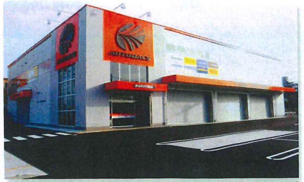
■ オートボックス様 蔵王店 (設計・監理) (有)青葉設計事務所 施工/S造2階建/延床面積:2,247㎡/福山市南蔵王町六丁目
