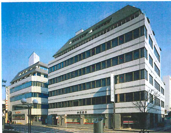
■山陽 第2ビル様 設計・施工/S造6階建/延床面積:2,241㎡/福山市三之丸町 ■山陽 第1ビル様 施工JV/RC造7階建/延床面積:3,996㎡/福山市三之丸町
