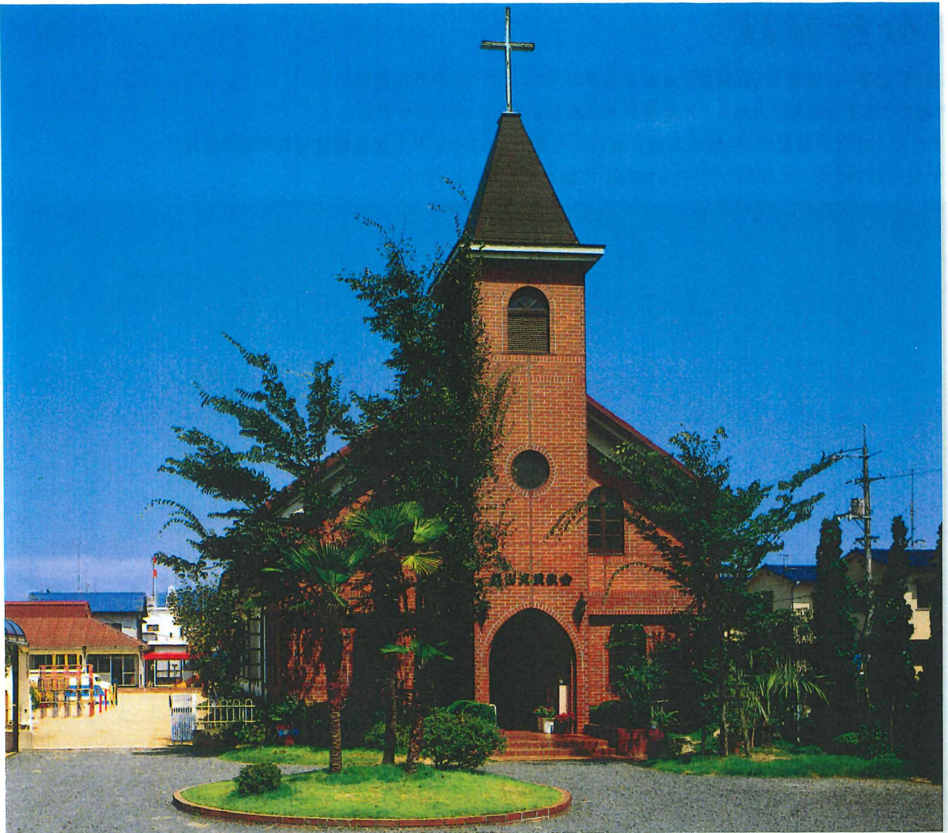
■福山天使幼稚園様 設計・施工/S造2階建/延床面積:620㎡/福山市草戸町二丁目
