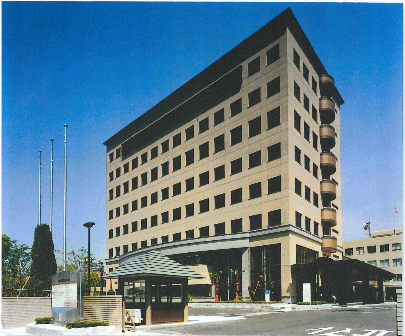
■ 広島県福山合同庁舎 施工JV/SRC造地下1階、地上8階建/延床面積:9,149㎡/福山市三吉町一丁目
