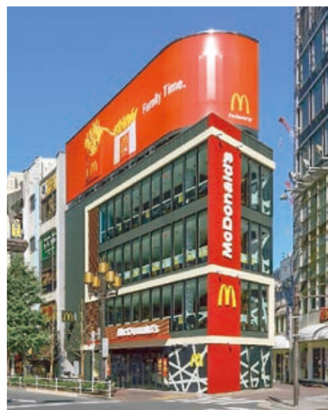
日本マクドナルド西武新宿駅前店新築工事(設計・施工)
