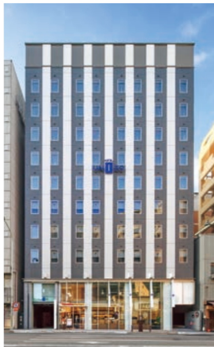
ホテルユニゾ京都四条烏丸新築工事*
