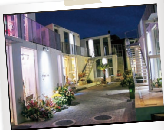
狭小地、個性的なデザイン sarugaku 新築工事 狭小現場、短い工期などの厳しい条件、 デザイン性の高い外観、構造が注目された (設計：平田晃久建築設計事務所)
