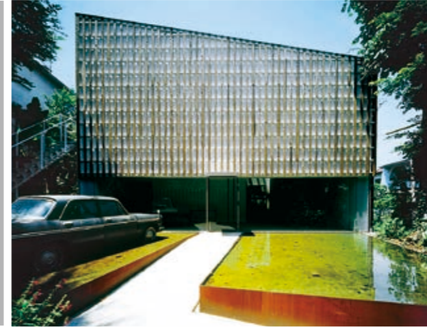
村井正誠記念美術館新築工事(設計:隈研吾建築都市設計事務所)
