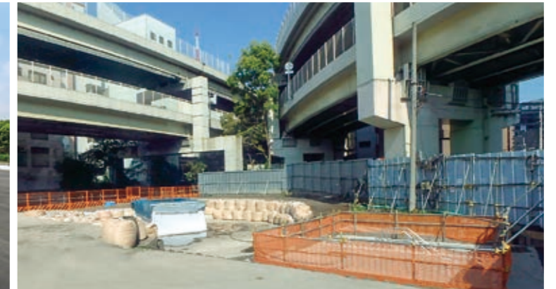
古川地下調節池工事 (その3-2) (東京都発注) 東京都建設局優良工事表彰
