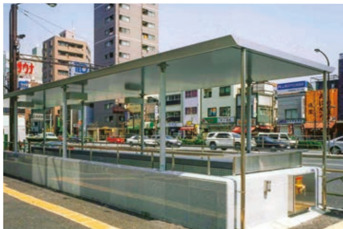
春日地下駐輪場 建築工事 (国土交通省発注)
