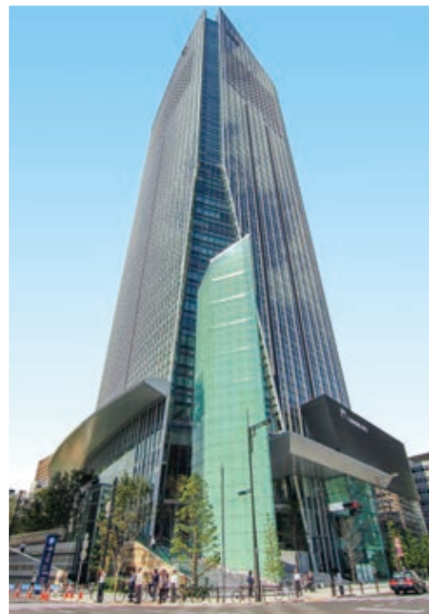
虎ノ門ヒルズ新築工事*、環状二号线換気塔新設工事
