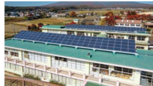
北杜市立小中学校(13校)太陽光発電設備設置工事(松下産業・東光電気工事株式会社JV、北杜市発注)
