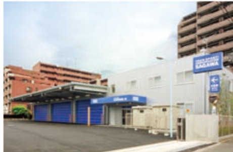
用賀グリーンセンター(仮称) 佐川急便世田谷店計画新築工事(設計・施工)
