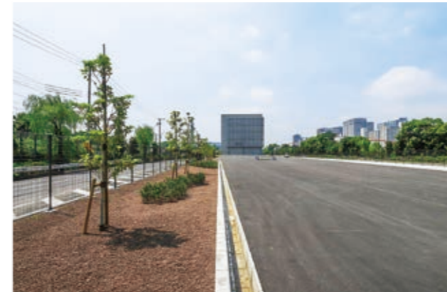
中央環状品川線大井北換気所外構整備工事 (東京都発注)
