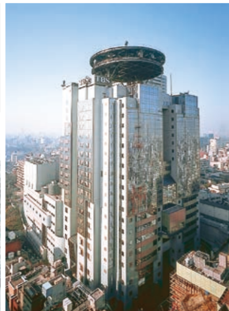
TBS放送センター新築工事の内地中連続壁工事*
