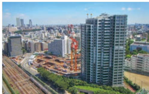
(仮称)大久保三丁目西地区開発計画A-1棟新築工事*
