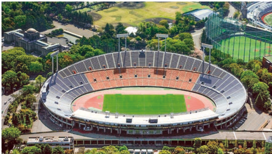
国立霞ヶ丘競技場 施設設備工事*
