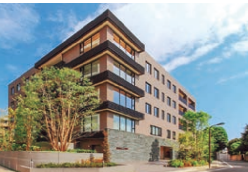
The Upper House新築工事(設計:陣設計)
