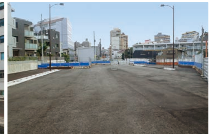
街路築造工事 (24三-環4河田町) (東京都発注)
