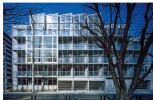
二葉アパートメント新築工事(設計:アトリエ・ヒューテック)
