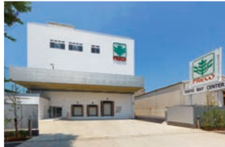
株式会社プレコファーズ東京ベイセンター(SGリアルティ新木場)新築工事(設計・施工)
