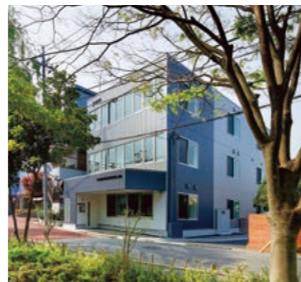
株式会社パワーテクノ本社建替え工事(設計・施工)
