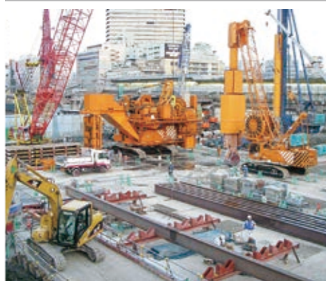
大阪駅新ビル新築工事の内地中連続壁工事*
