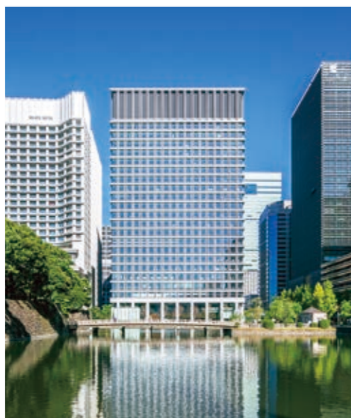
日本生命丸の内ガーデンタワー新築工事*
