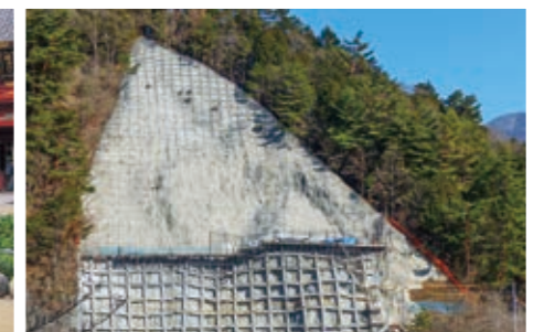
道路災害防除工事 (24西の6) (東京都発注)
