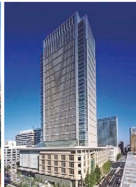
丸の内ビルディング新築工事の内地中連続壁工事*
