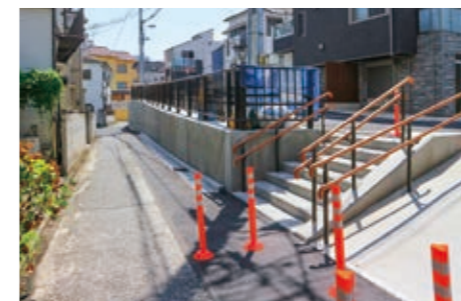
文京区本郷4丁目擁壁改修工事 (区道653号外) (文京区発注)
