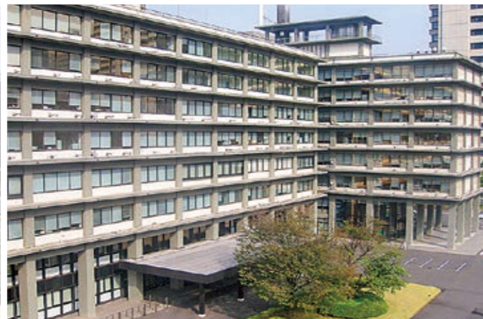
外務本省改修(09)建築工事 (国土交通省発注) 国土交通省大臣官房官庁営繕部長表彰
