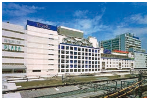
東武百貨店外壁改修、レストラン街スパイス設備改修工事*
