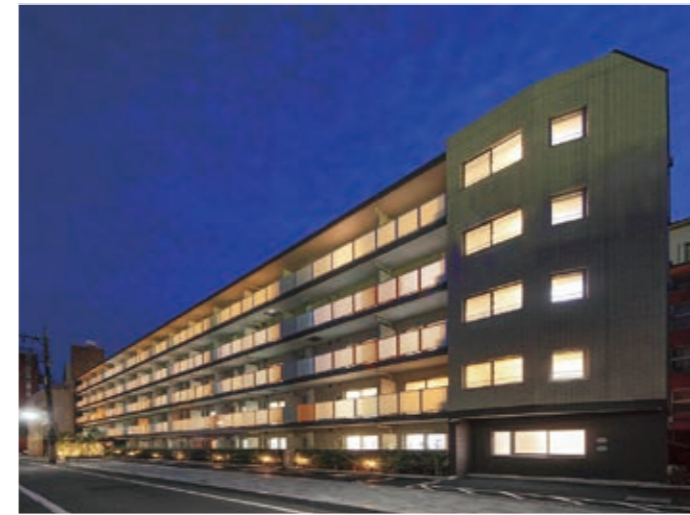
ガリシア品川戸越新築工事(グループ会社 アーバンアセット研究所 発注、設計:Di-Frame)
