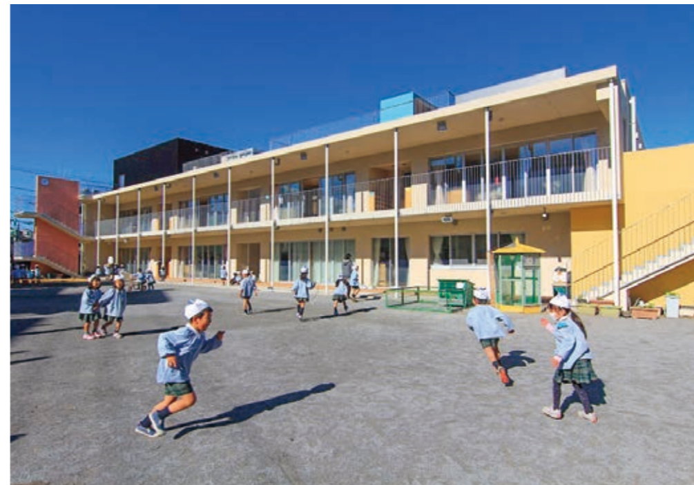
寿福寺幼稚園新築工事(設計:石原・山口計画研究所)
