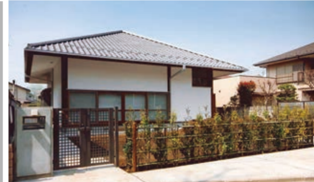
白の家 移築新築工事(原設計:篠原一男、移築監修:白澤宏規、 移築設計:澤田佳久建築研究所、TOMO空間研究所)
