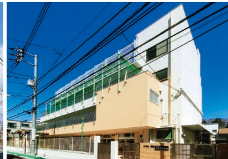
文京区目白台保育園・児童館耐震補強その他改修工事(文京区発注)
