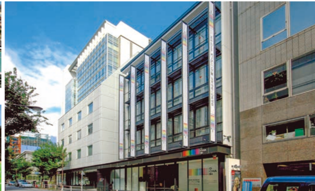
服部学園御茶ノ水校新築工事および既存棟リニューアル工事(設計:栽花建築設計事務所)
