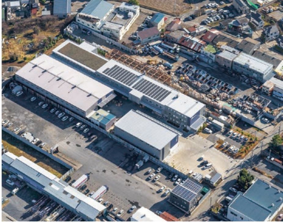
アイヨンテック朝霞工場増築工事、A棟建替工事、既存棟改修工事(設計・施工)
