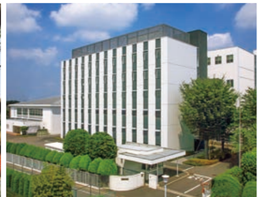
三菱電機ビルテクノサービス 小平研修棟新築工事(設計:三菱地所設計)*
