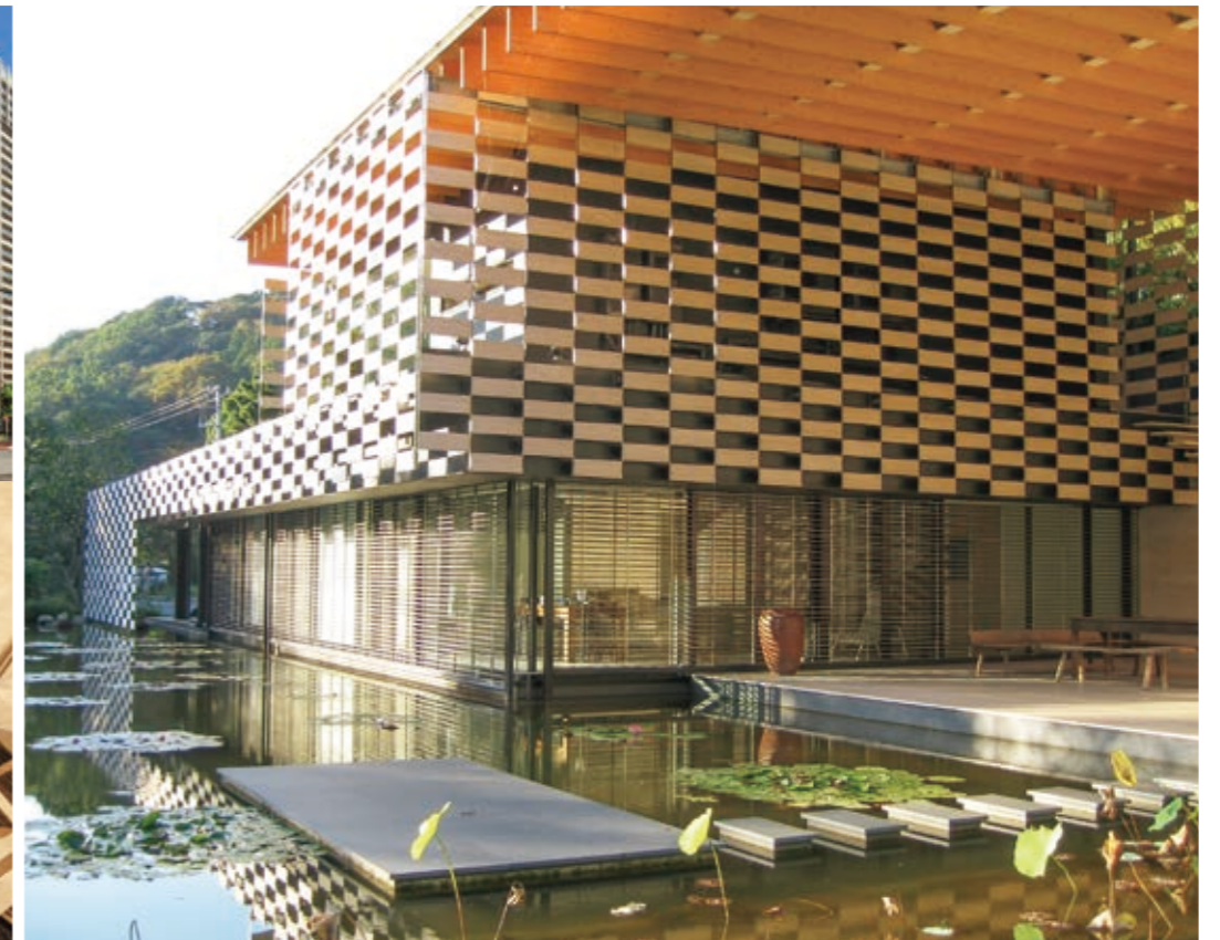
LOTUS-HOUSE新築工事(設計:隈研吾建築都市設計事務所)
