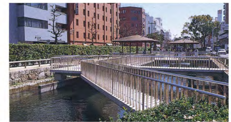
西川緑道公園水上テラス
