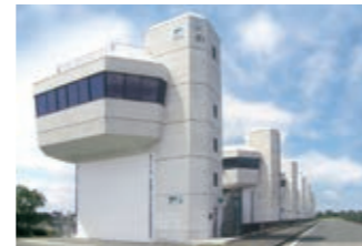
ぼろ僧川水門耐震補強工事
