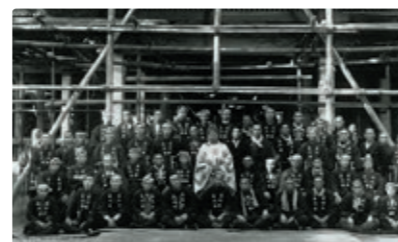
天神社建設工事 (昭和8年)
