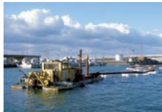
福田漁港単漁港整備工事
