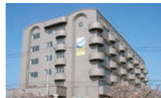
磐田東高本館校舎
