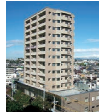
サーラプラザ磐田複合ビル
