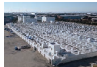
磐南浄化センター
