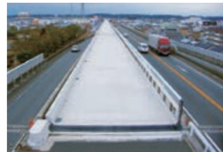
国道1号袋井バイパス掘越床版
