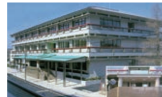
磐田市役所西庁舎
