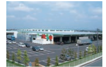
JA集出荷・管理施設
