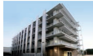
光創起イノベーション研究拠点棟
