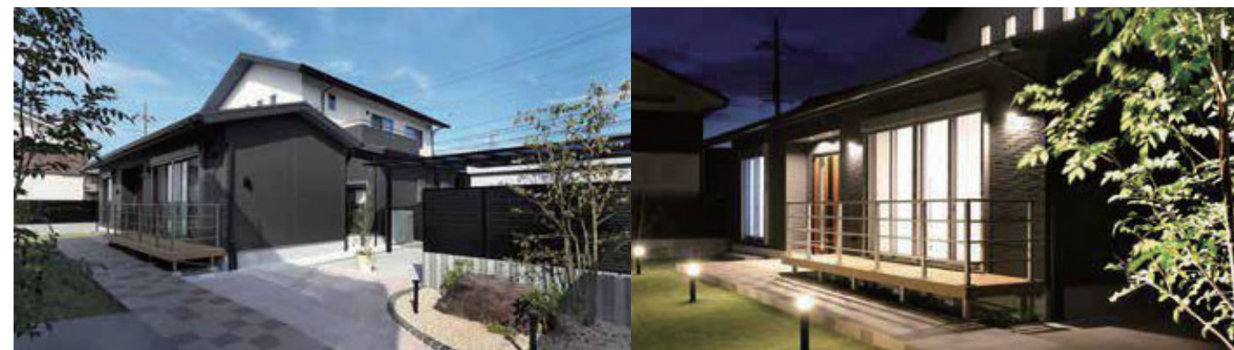
■ Y邸 新築工事
