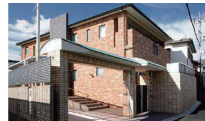
■ S邸 新築工事
