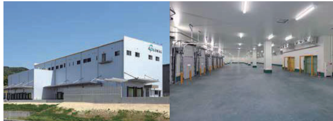
■ 株式会社熊谷運輸 城陽市倉庫
