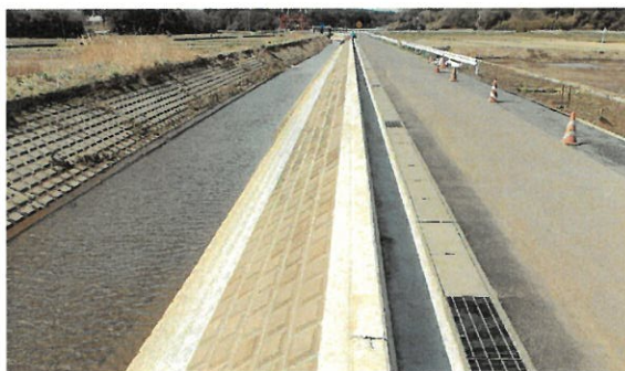
東新川改修工事(東海村)
