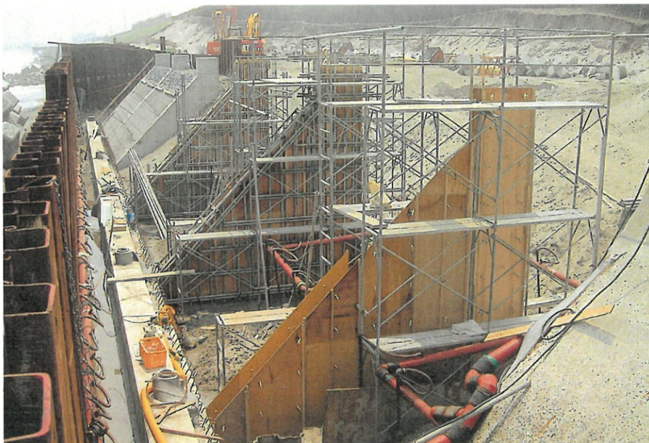
林地荒廃防止施設災害復旧工事(東海村)
