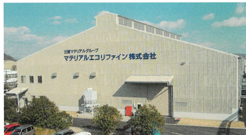
レアメタルリサイクル工場(いわき市)
