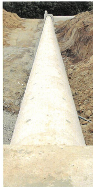
東海村雨水排水管整備工事(東海村)
