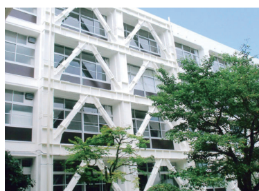
耐震補強工事
