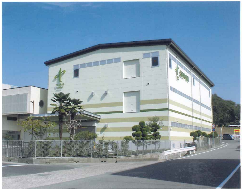
(株)田中印刷新工場 新築工事
