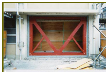
▲写真-③:K型ブレース
