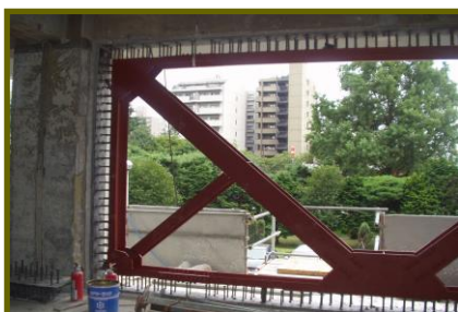
■写真-⑤:ハイブリッドブレース (騒音の大きいあと施工アンカーを減らします。)
