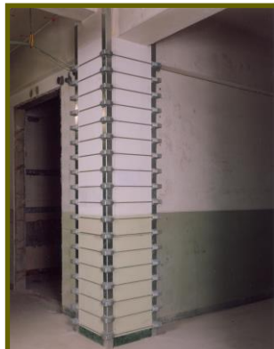
■写真-⑧:AC耐震補強
