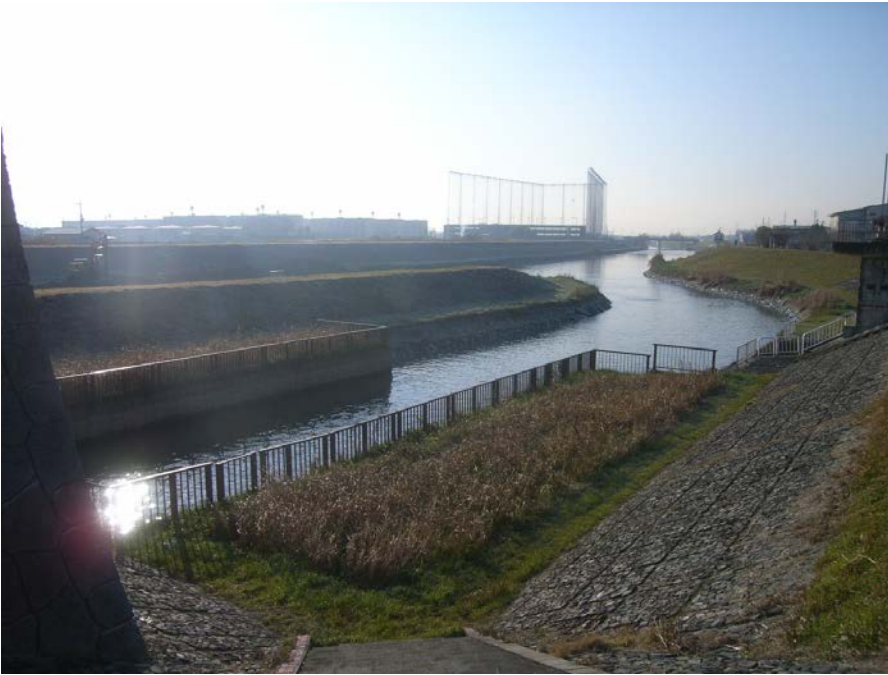
●稗田地区外掘削護岸工事
