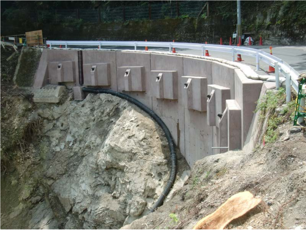
●大台ヶ原公園川上線道路災害復旧事業工事
