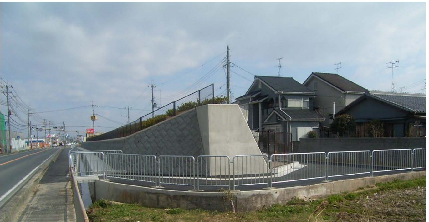
●大和御所道路川西地区路側整備工事
