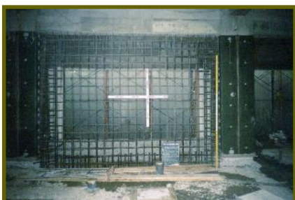
▲写真-①:耐震壁の新設
