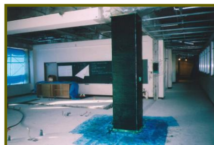
■写真-⑥:炭素繊維シート貼り
