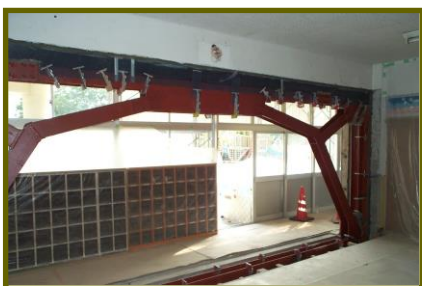
▲写真-④:マンサード型ブレース
