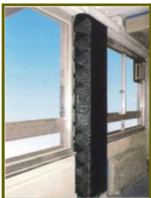
■写真-⑦:炭素繊維シート貼り (SR-CF工法)
