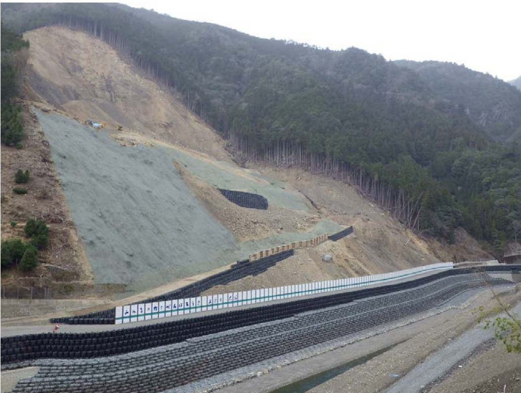
●熊野川清水地区土砂災害緊急対策護岸工事
