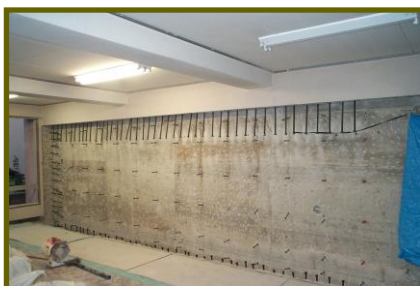
▲写真-②:耐震壁の増し厚
