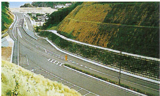
瀬戸ヶ島道路
