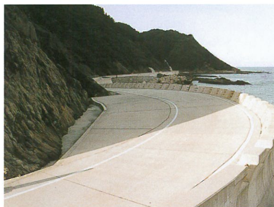
小伊津漁港関連道路
