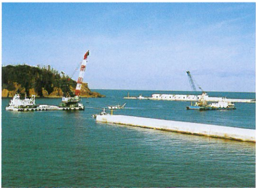
瀬戸ヶ島北防波堤北護岸
