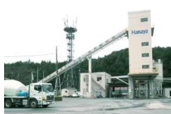
生コンクリート工場 栃木県矢板市片岡1868
