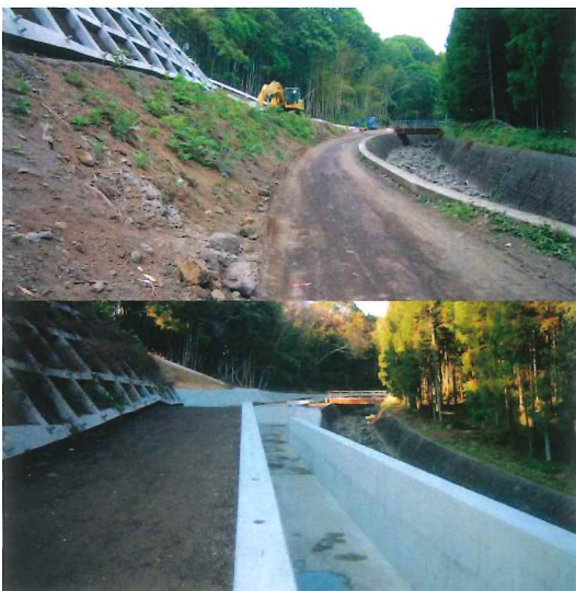
治水対策導水路築造工事 構造/鉄筋コンクリート造
