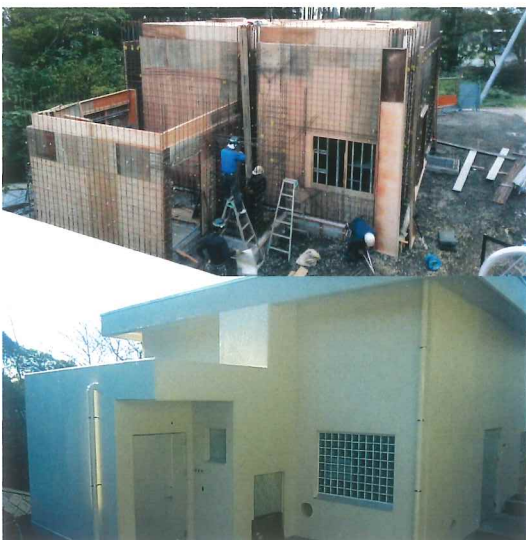
桑崎2号水源地送水ポンプ棟建築工事 構造/鉄筋コンクリート造
