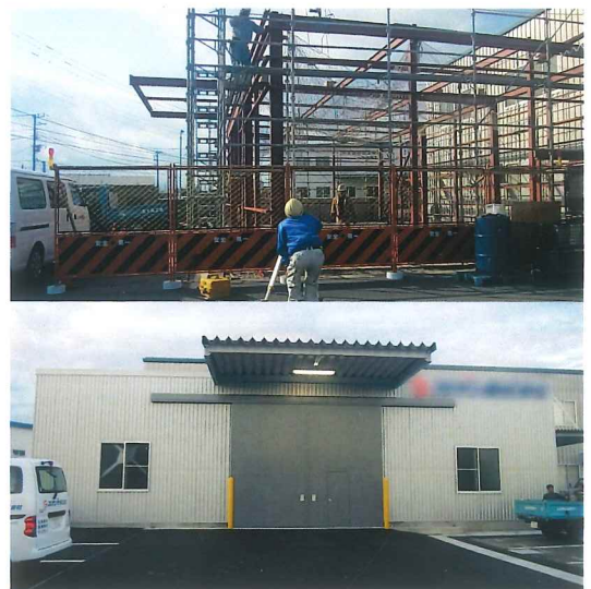
製品倉庫新築工事 構造/鉄骨造
