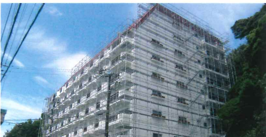
マンション外壁改修工事 工法/弾性塗料吹付
