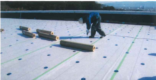
富士市斎場屋上防水改修工事 工法/塩ビシート機械固定工法
