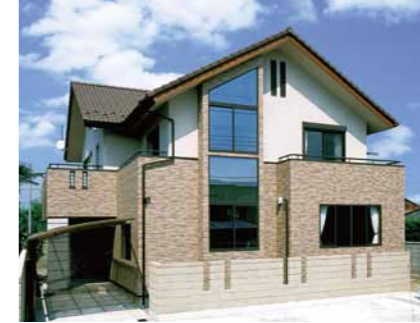
住宅・マンション
