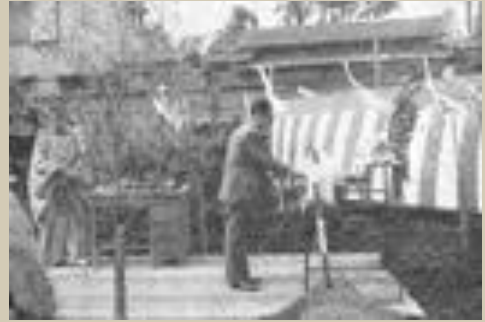
● 埼玉建設会館施工
