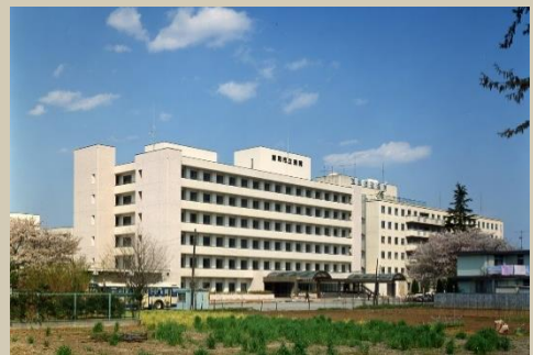
● 浦和市立病院施工
