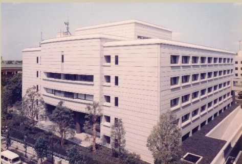
● 埼玉県議会会議事堂施工
