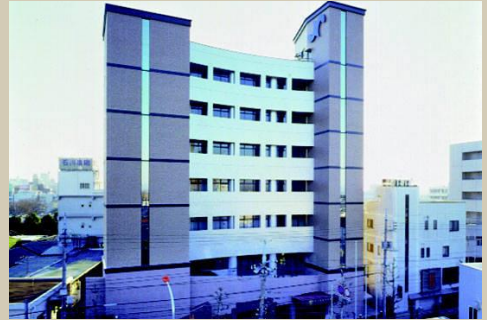
●浦和商工会議所会館施工
