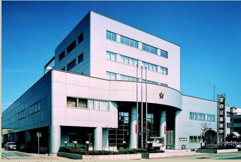
●浦和警察署庁舎施工
