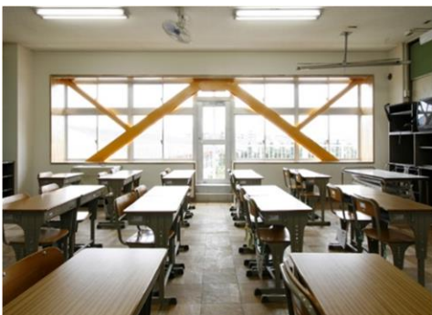
▲ 耐震補強工事 (小学校校舎)
