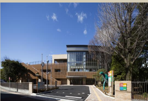
●戸田市こどもの国施工
