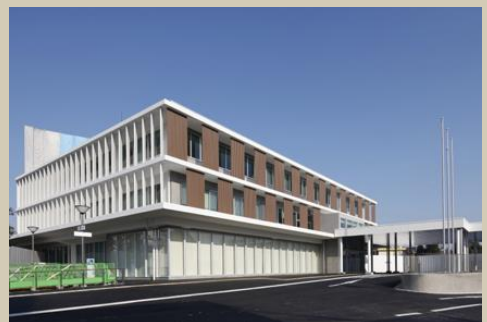
●ふじみ野市庁舎施工
