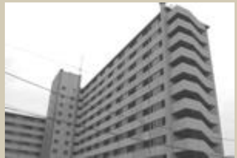
● 県営与野高層住宅施工 (竹中工務店とJVを組み、県内初の鉄骨鉄筋コンクリート造)
