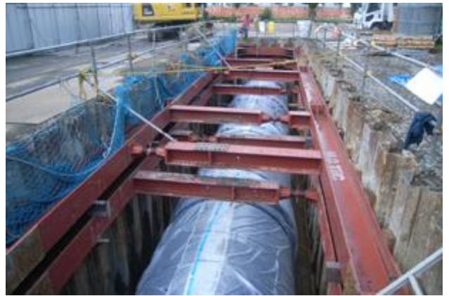
▲ 地下埋設物布設工事
