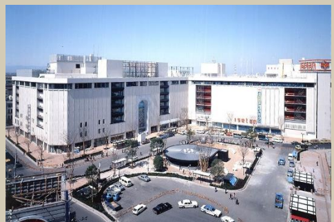
● 浦和駅西口再開発事業 浦和コルソ施工
