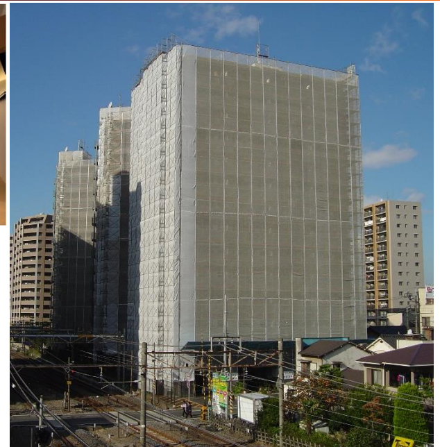
▲ 外壁・屋上防水工事 (マンション)
