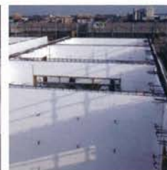
ジャストブリード施工の様子
