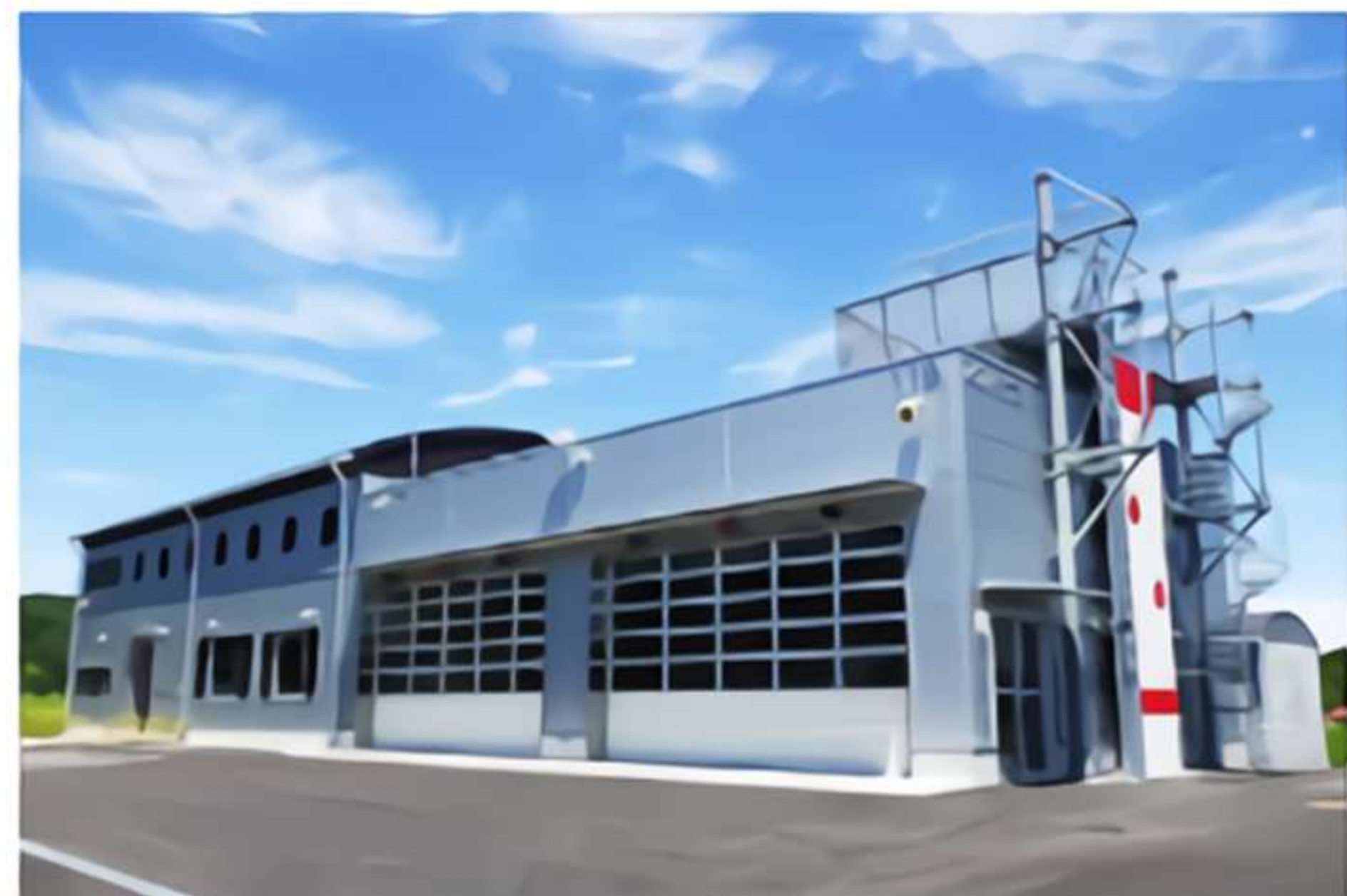
消防署小糸分署 新築工事
