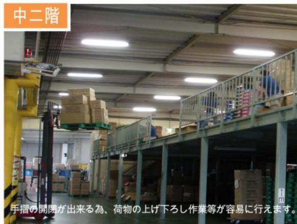
手摺の開閉が出来る為、荷物の上げ下ろし作業等が容易に行えます。
