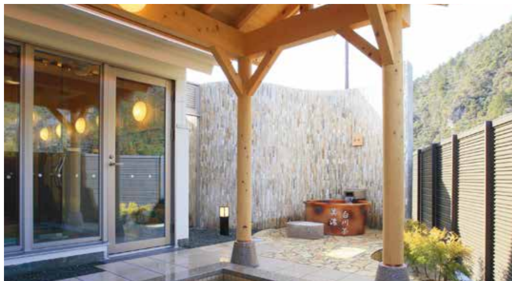
美濃白川温泉施設 (白川町)増築工事
