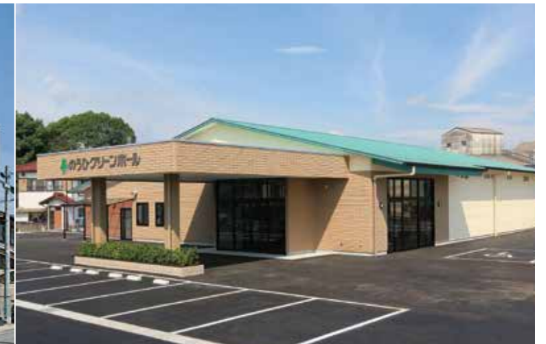
のうびグリーンホール(美濃加茂市)
