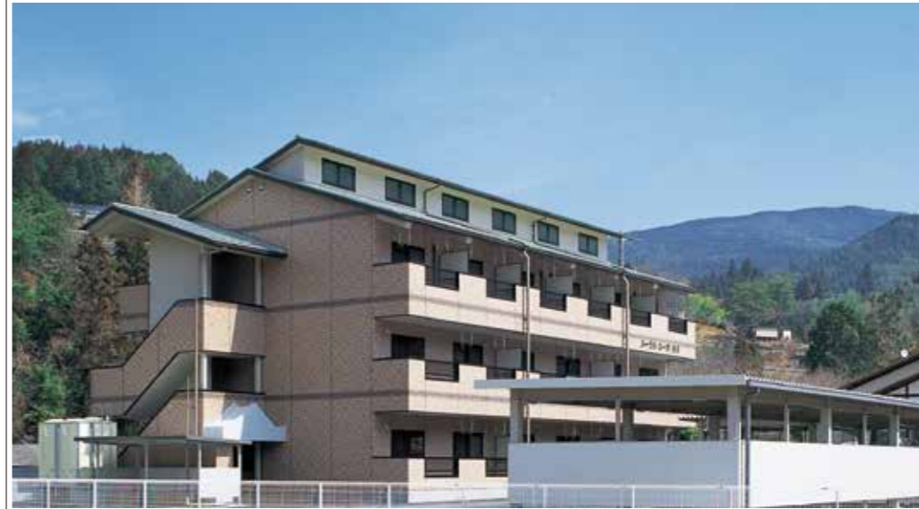
赤河町営住宅 (白川町)
