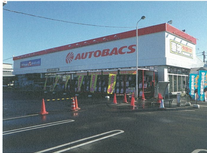
オートバックス小田原店駐車場舗装工事
