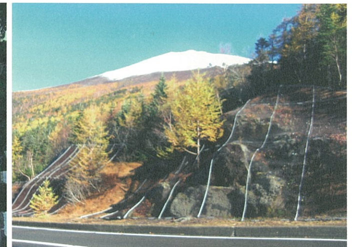
富士公園太郎坊線“安全・安心の道”緊急対策事業工事
