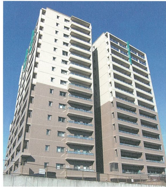
POLESTARマンション新築工事
