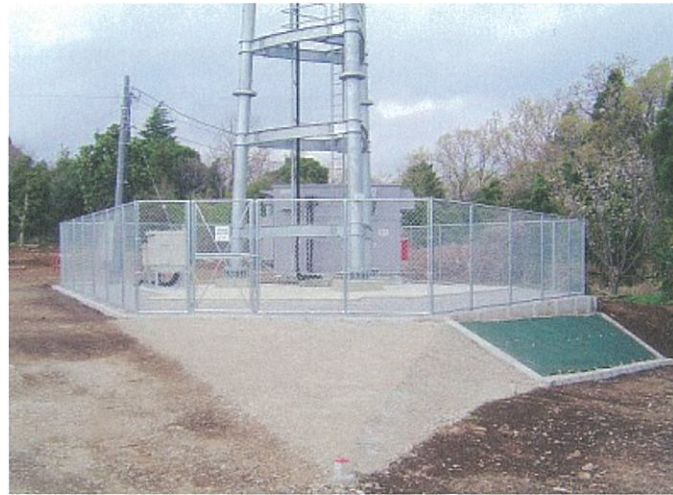
長泉IMT基地局建物工事
