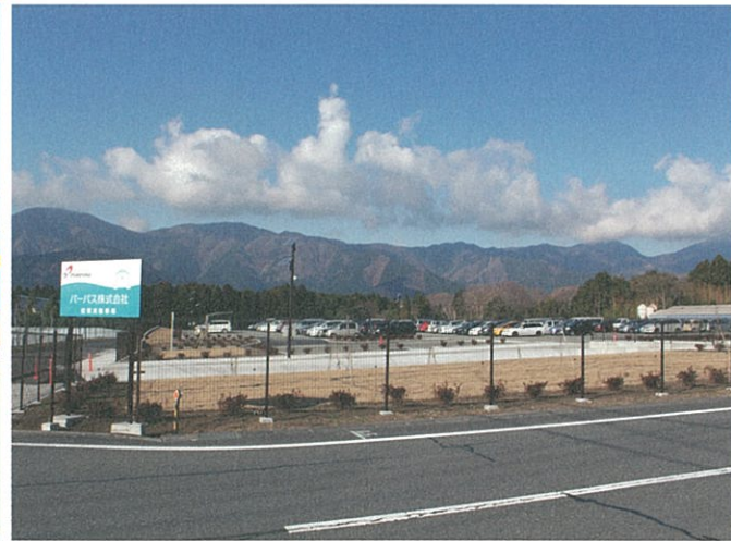
パーパス株式会社駐車場新設工事
