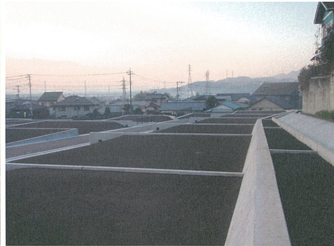
小泉宅地分譲敷地造成工事
