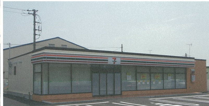
セブンイレブン厚原店新築工事
