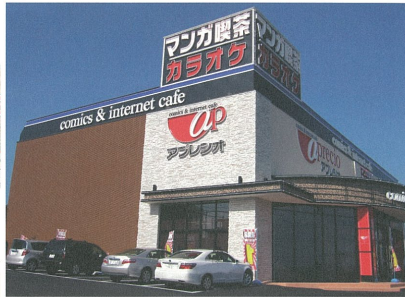
アプレシオ富士宮店新築工事
