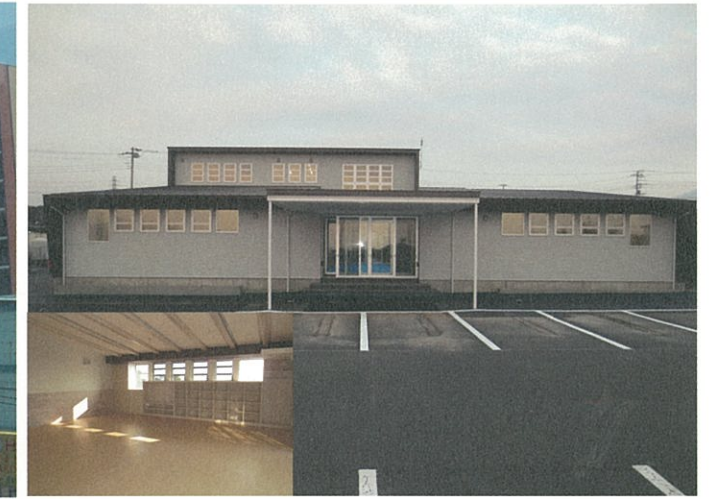
社会福祉法人誠信会みらい新築工事
