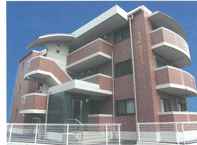
沼津マンション新築工事
