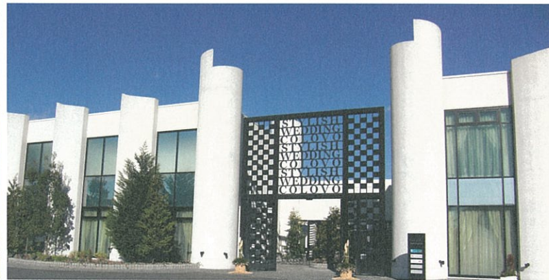
結婚式場COLOVO新築工事
