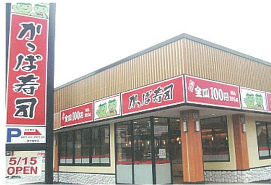
かっぱ寿司柚木店新築工事
