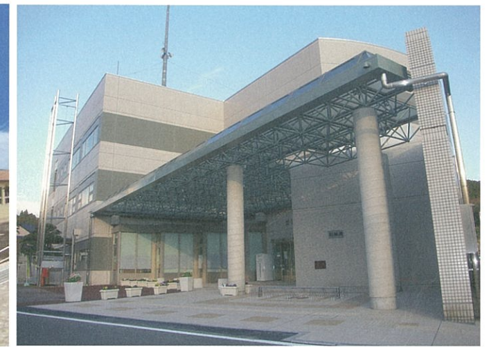
富士宮市芝川会館改修工事
