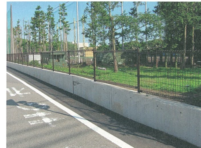
富士宮北高等学校北側フェンス設置工事
