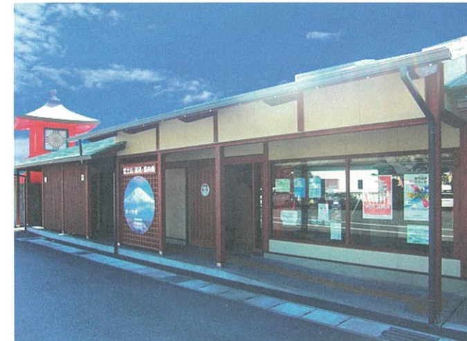
富士山本宮浅間大社観光誘客施設整備工事
