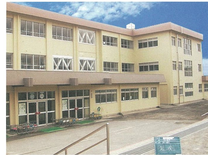
富士宮市立富士見小学校校舎耐震補強工事
