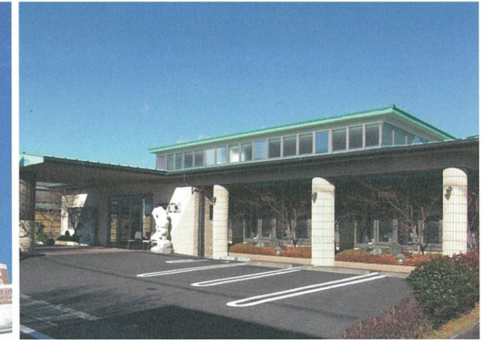
介護福祉施設にしき新築工事
