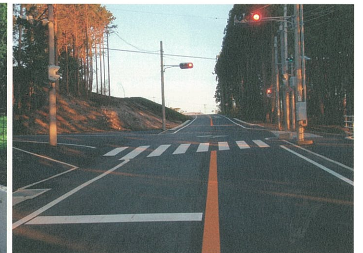
1級市道青木馬見塚線改良工事
