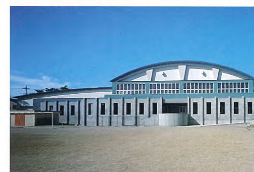
甲斐市立竜王中学校屋内運動場
