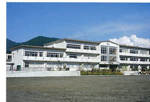
甲府市立北新小学校校舎
