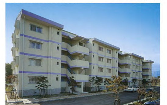
増穂町営住宅若宮団地
