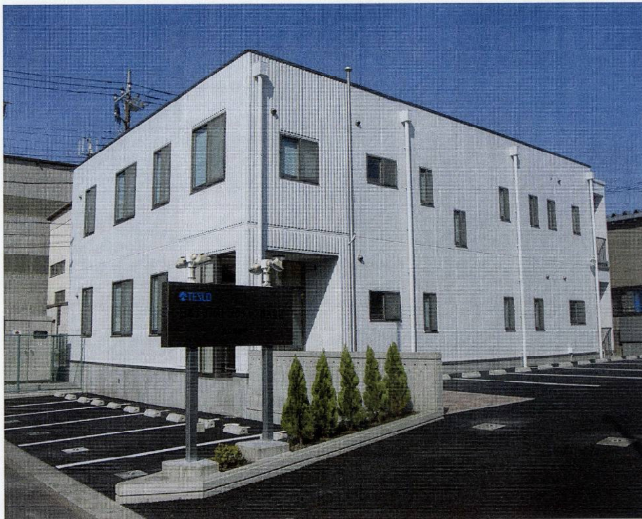
事務所新築工事 N株式会社殿
