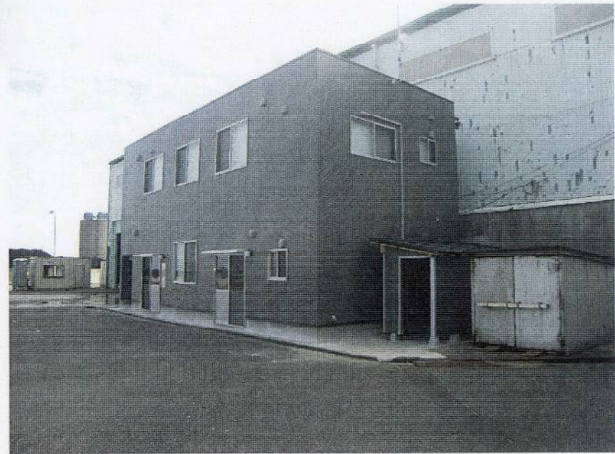
事務所新築工事 H株式会社殿
