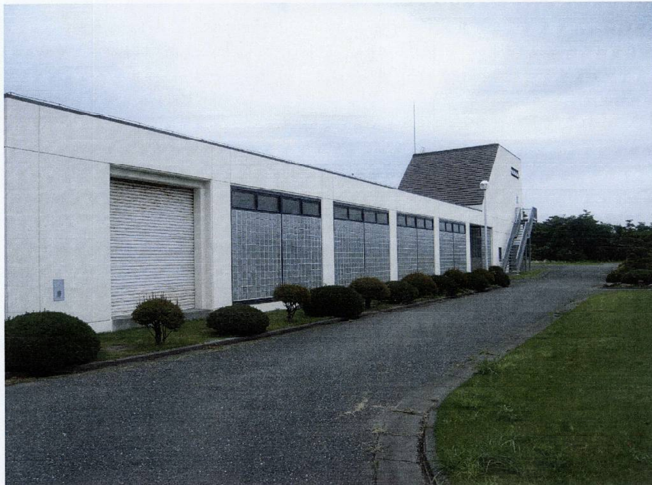
沈砂池・ブロー棟雨漏改修工事 日立・高萩広域下水道組合殿
