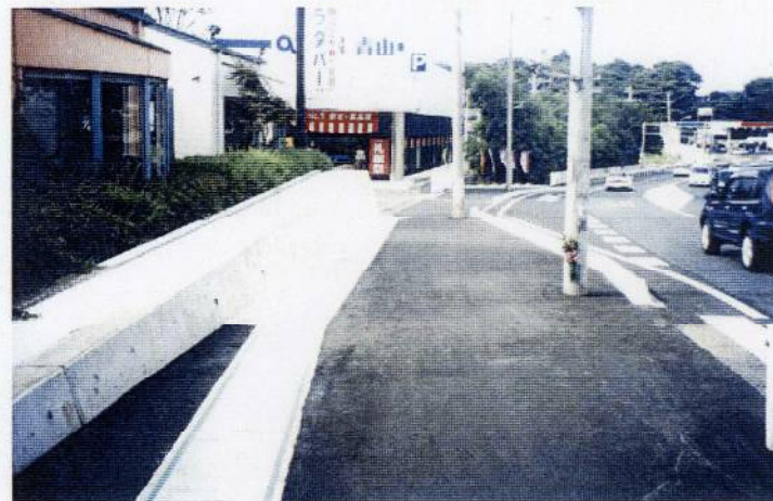
国道245号線バスレーン設置工事 茨城県殿
