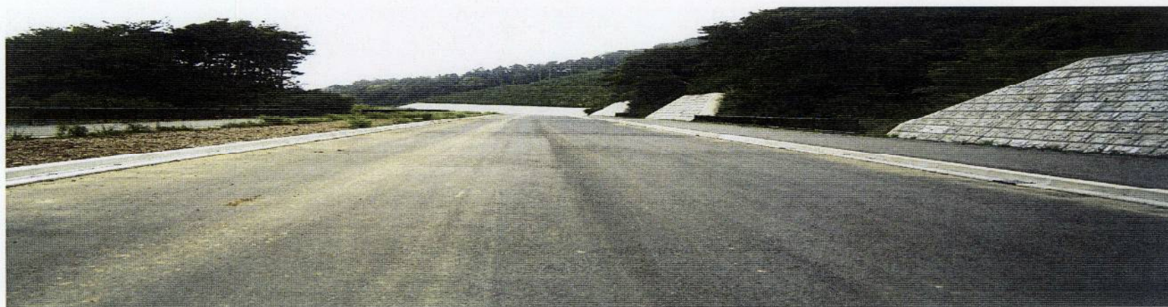
石名坂バイパス道路新設工事 日立市殿
