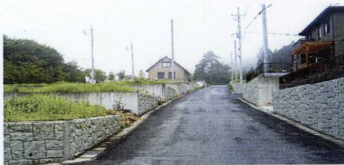
グリーンタウン造成工事 日立市殿
