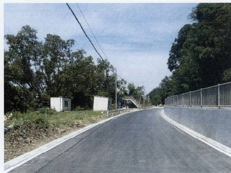
市道7175号線道路改築工事 日立市殿
