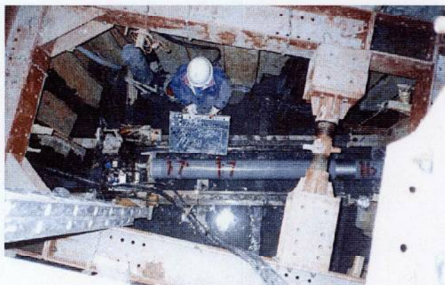
下水道 推進工事 日立市殿
