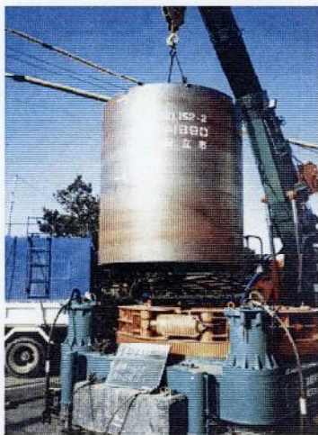
下水道 立坑工事 ケコム工法 日立市殿
