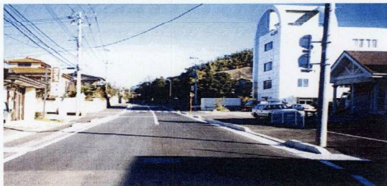
県道日立・いわき線道路改良工事 茨城県殿
