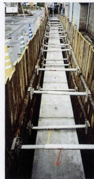
日立市内幹線排水工事 日立市殿
