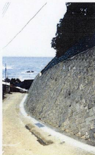
浜の宮法面工事 日上市殿
