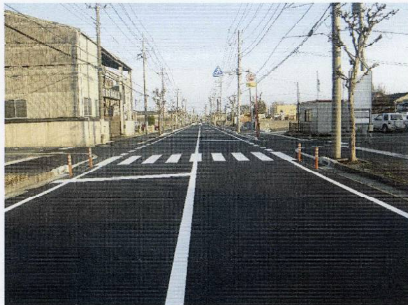
市道4863号線舗装整備工事 日立市殿
