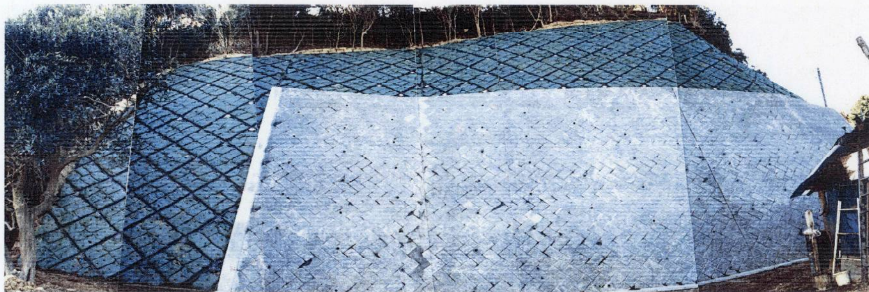
東町急傾斜工事 H=16m 日上市殿
