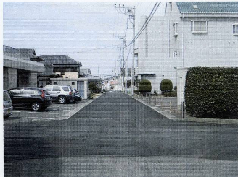
市道7710号線舗装整備工事 日立市殿
