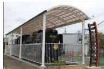
機関車車庫新築工事(有田川町)
