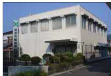
耐震工事(新宮市)
