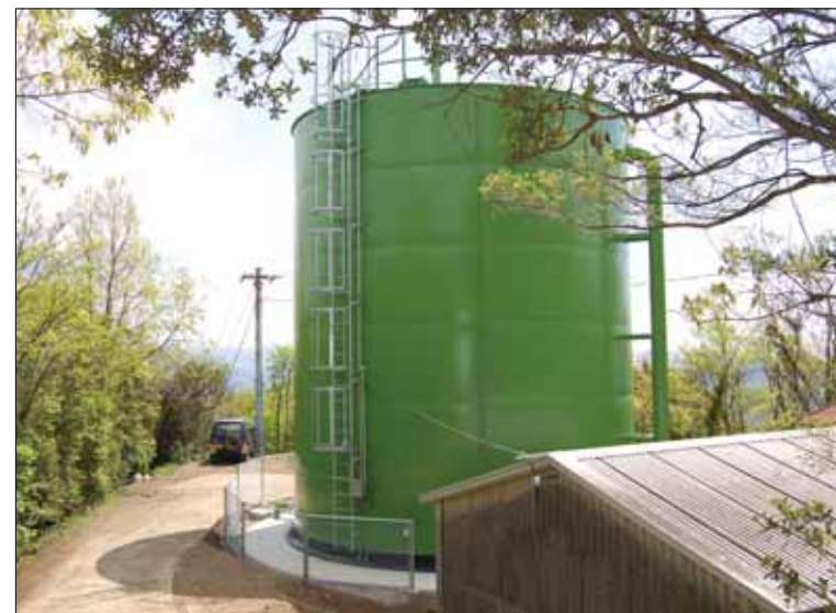
タンク施設工事
