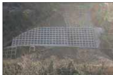
法面工事(和歌山県)
