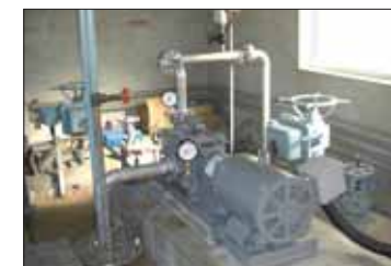
工業用ポンプ据え替え工事
