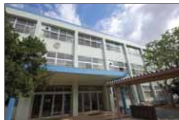
小学校耐震改修(湯浅町)
