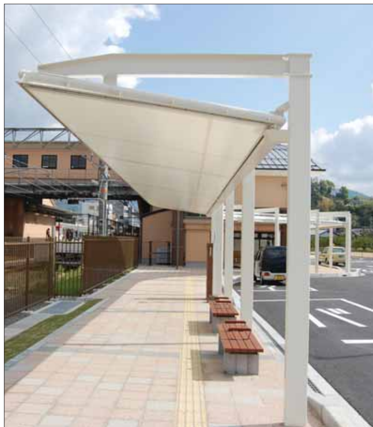
藤並駅東口周辺整備工事(有田川町)
