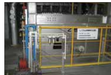
プラント施設修繕工事
