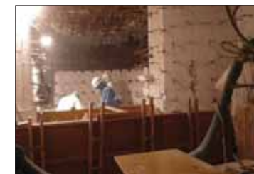
焼却炉内築炉工事
