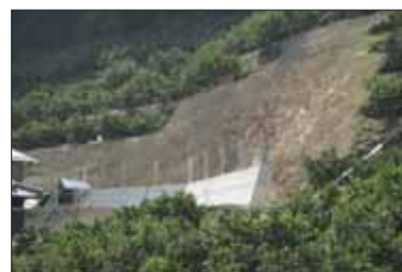
擁壁工事(和歌山県)
