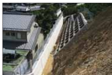
法面工事(和歌山県)
