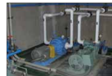
工業用ポンプ据え替え工事
