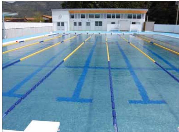
プール新築工事(有田川町)
