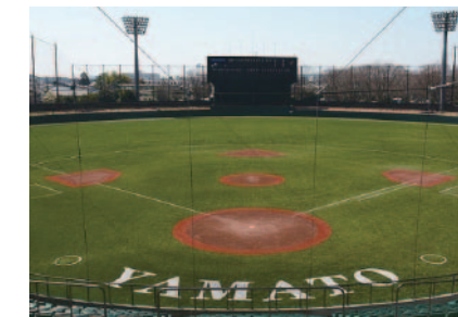
引地台野球場 施設大規模改修工事 野球場 人工芝舗装工事 規模:12,348m 2
