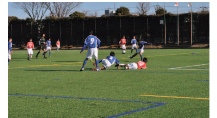
秋葉台公園球技場 人工芝生化改修工事 人工芝舗装 規模:A=11,001m 2
