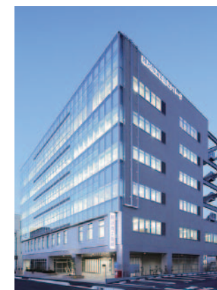
藤沢商工会館 ミナパーク 事務所・物販・飲食・集会場 鉄骨造 地下1階地上6階建て 延床面積:5,968.68㎡ (株)平山建築設計事務所
