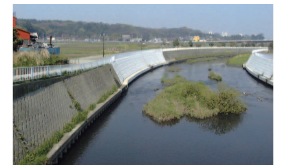
総合治水対策特定河川工事 工種:護岸工事 規模:工事延長L=68.7m
