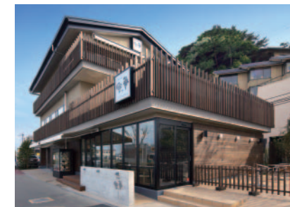
魚華 飲食店 鉄骨造 地上3階建て 延床面積:467.94㎡ (株)南條設計室
