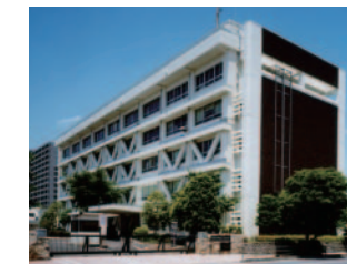
藤沢合同庁舎 改修及び 耐震補強工事
