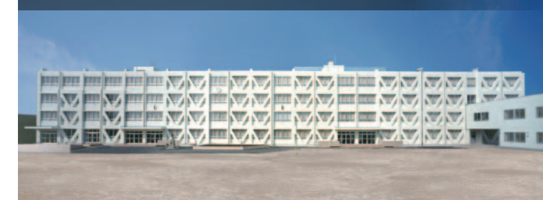
御所見小学校大規模改修建築工事 耐震補強等工事 小学校 鉄筋コンクリート造 地上4階建て
