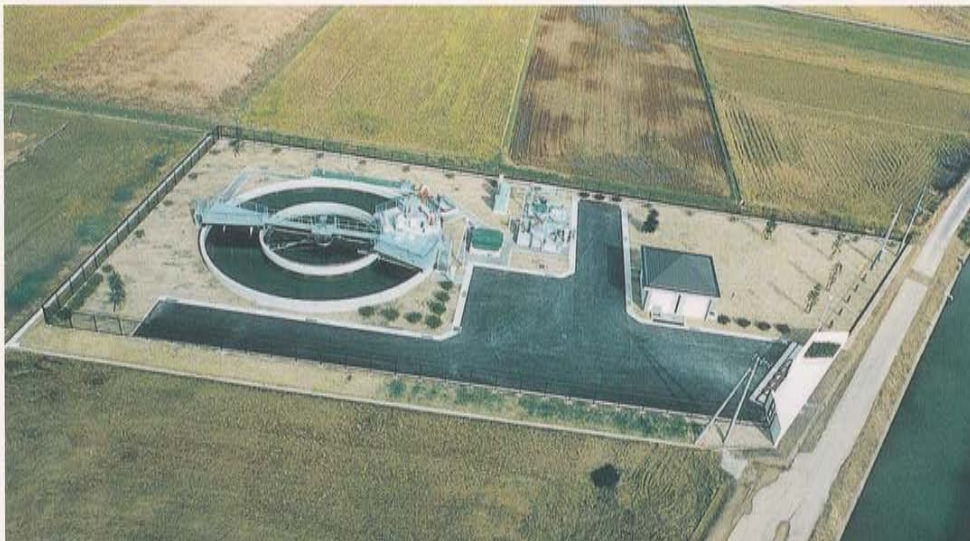
河浦町一町田浄化センター建設工事
