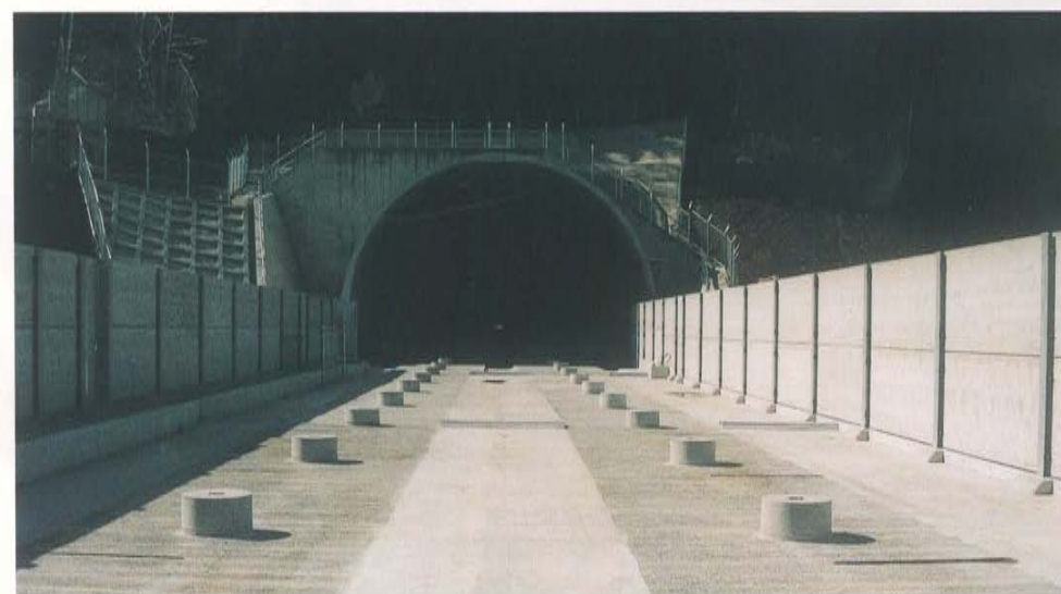
九州新幹線水俣トンネル工事
