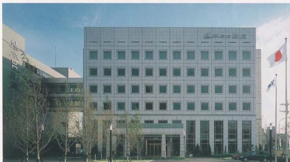
(株)熊本日日新聞社本社ビル新築工事(企業体工事)
