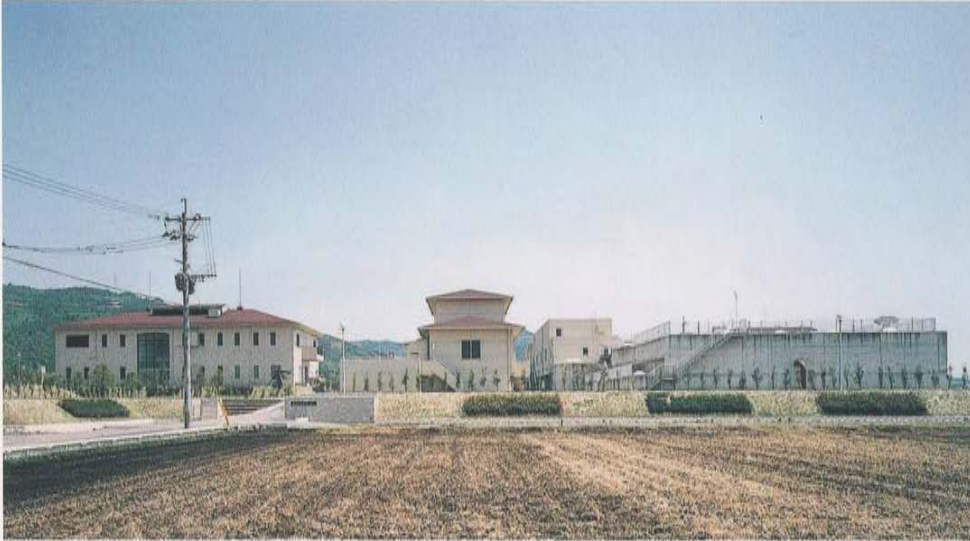
益城町益城終末処理場建設工事
