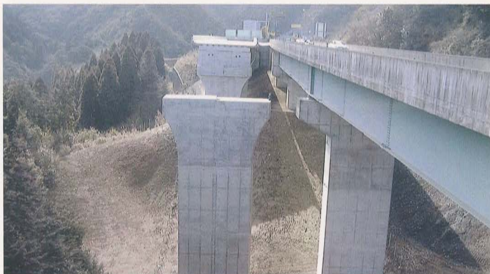
九州自動車道小川内第四橋工事
