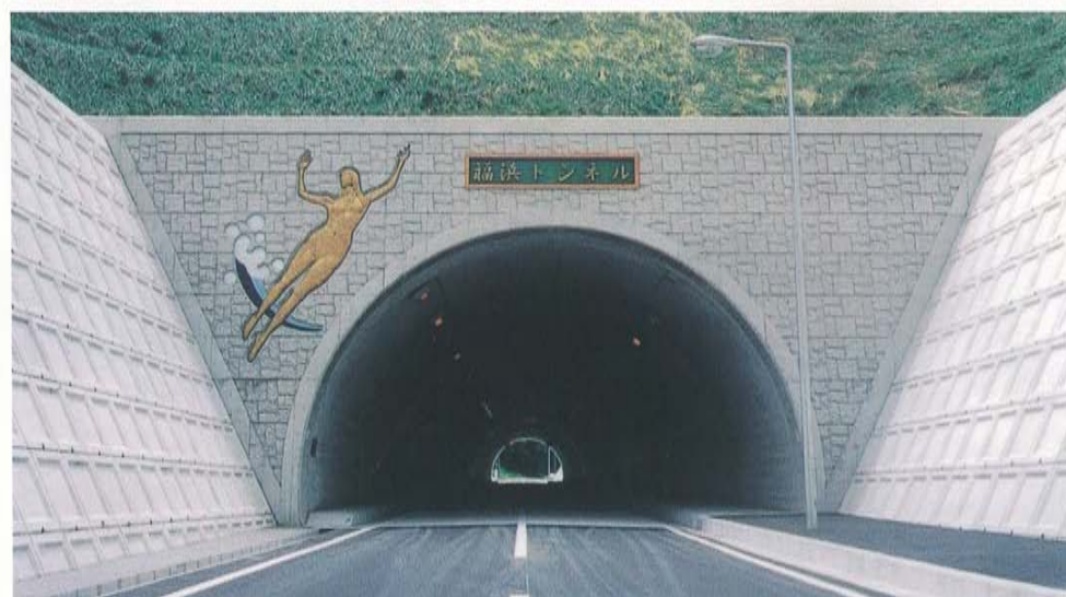
芦北地区広域農道福浜トンネル工事
