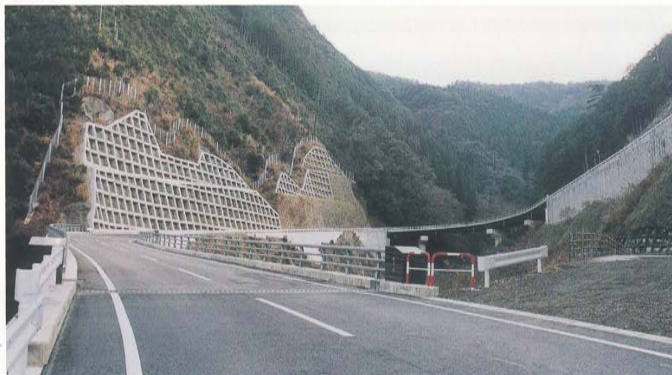
中河間多良木線道路整備工事
