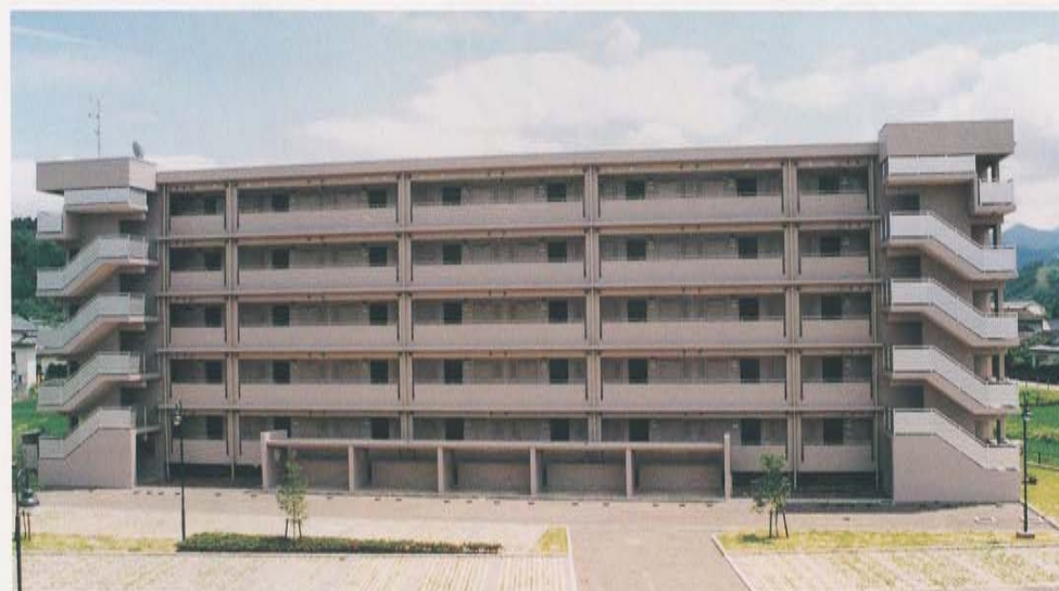
県職員人吉单身者用住宅建設工事
