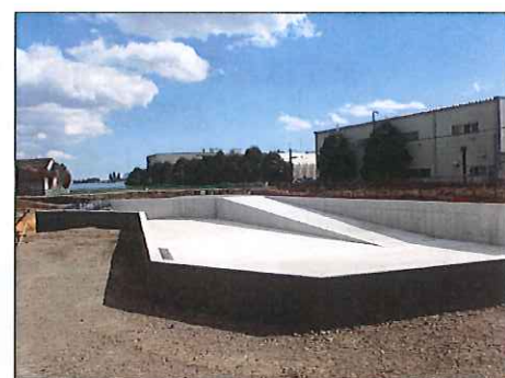
千渡雨水第二調整池建設工事その2
