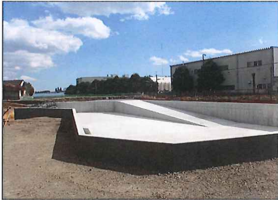
千渡雨水第二調整池建設工事その2
