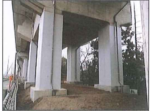
大宮・小山間幸手高架橋外橋脚補強 その他工事(ユニオン建設)
