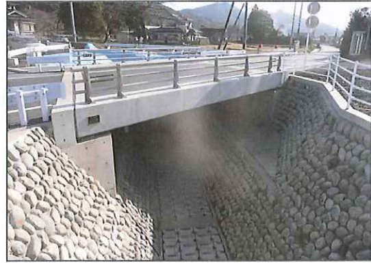
19年度 国庫補助通常砂防工事桑が沢その1
