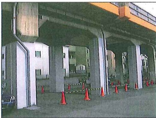
南浦和・東浦和間南浦和東第9高架橋 橋脚補強工事(ユニオン建設)
