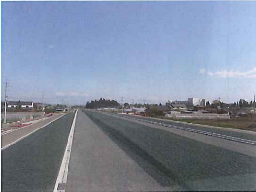
道路改良工事 293号南BPその5
