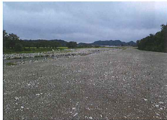
堆積土除去工事 大芦川その7
