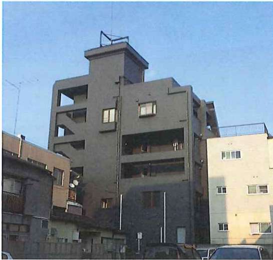
ハヤシ・ビジネス・マネジメント 様 (ビル改修工事／内・外部大規模リニューアル)
