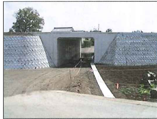
平21 道路改良工事 293号鹿沼南BPその1
