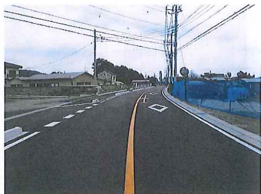
道路改良工事板荷玉田線その1
