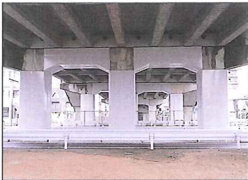
緊急地方道路整備工事 JR小山耐震補強工事 (ユニオン建設)
