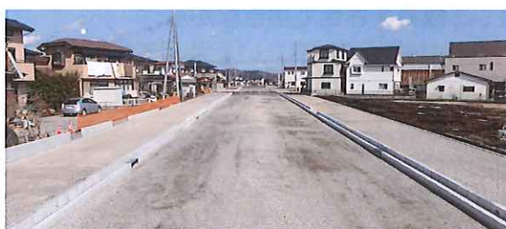
道路改良工事 古峰原宮通りその1
