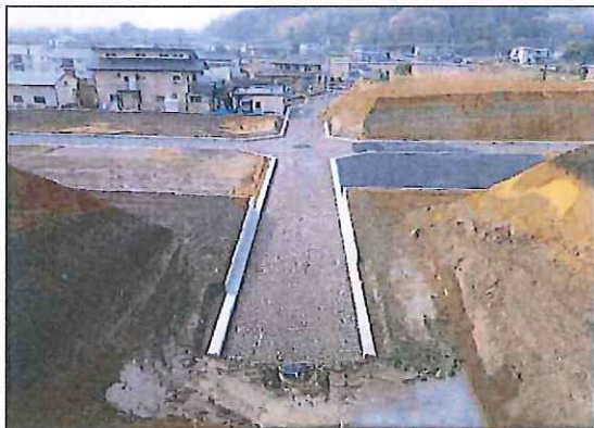
平成22年度新鹿沼駅西地区区画道路6-43外 築造工事
