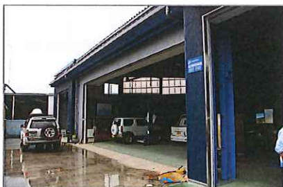
阿久津自動車 様 (増改築工事／ 建物一部解体・改築、 舗装工事)
