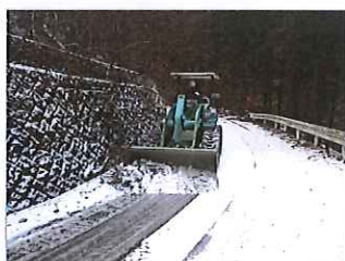
除雪作業・災害復旧
