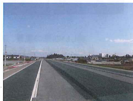
道路改良工事 293号南BPその5
