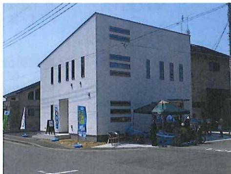
T様店舗併用住宅新築工事
