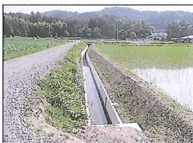
19年度 県営経営体基盤 西沢第5工区圍整工事
