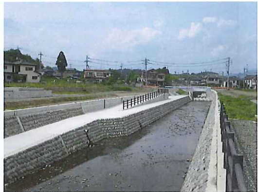
護岸工事 小藪川その1
