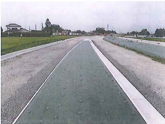
道路改良工事 293号南BPその4
