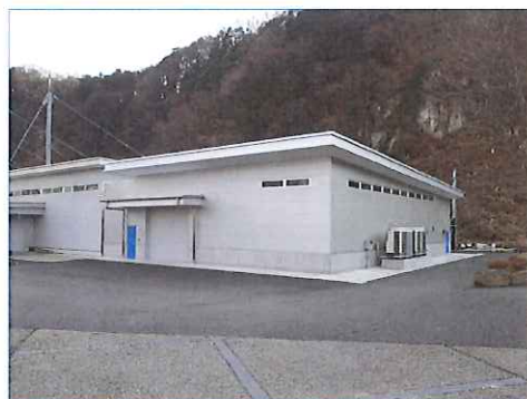
(株)ナカニシCNC棟増築工事
