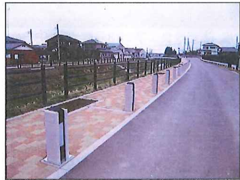
新鹿沼駅西地区6-30号線河川遊歩道 整備工事
