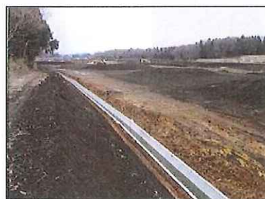
19年度 県営経営体基盤 北赤塚第4工区圍整工事
