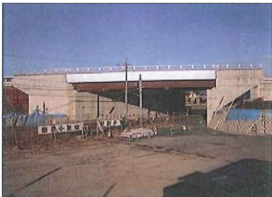
東北線氏家・蒲須坂間国道4号線二道橋床版工事 (ユニオン建設)
