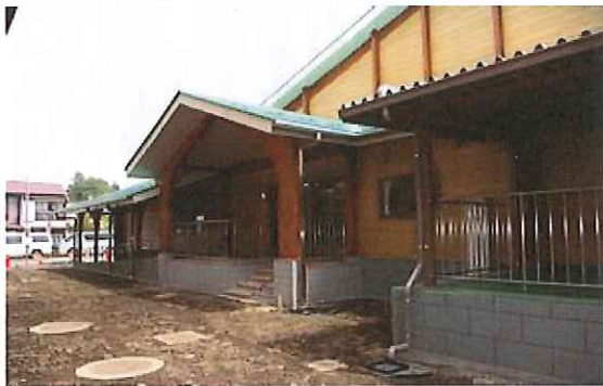
鹿沼市立中央小学校屋内運動場
