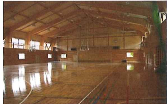
鹿沼市立中央小学校屋内運動場
