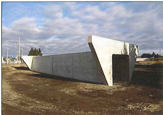
20年度 道路改良工事293号鹿沼南BPその1
