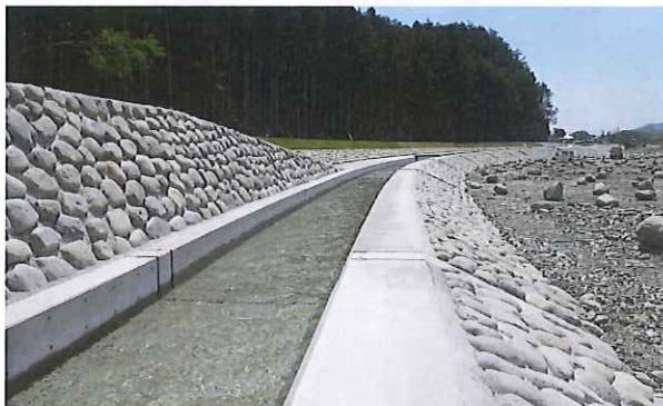
護岸工事 大芦川その3
