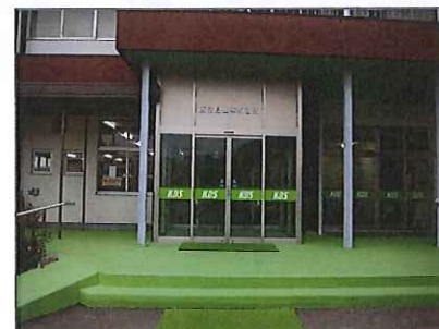
鹿沼自動車教習所 様 (改修工事)
