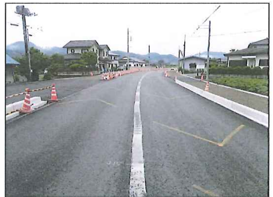
道路改良工事 鹿沼足尾線その2
