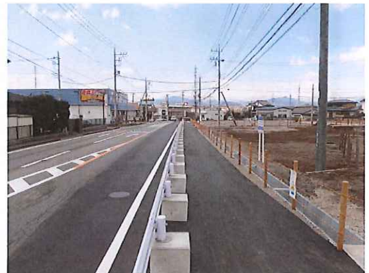
道路改良工事 古峰原宮通りその1
