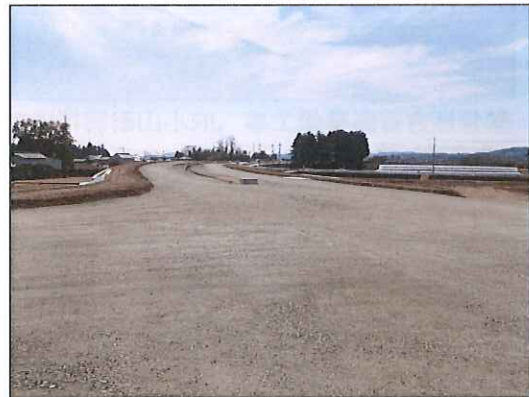
道路改良工事 293号鹿沼南BPその2
