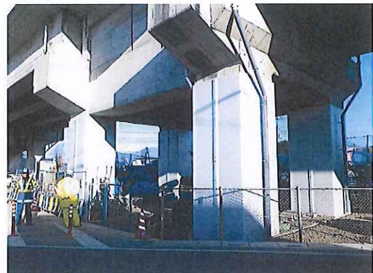
幸手高架橋外補強工事 その4 (ユニオン建設)
