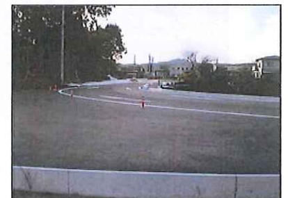
平20 3009号線舗装改修工事
