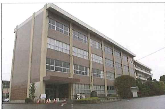
栃木県立真岡工業高校(耐震改修工事)
