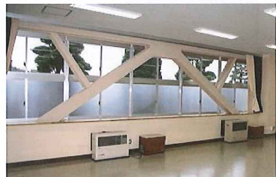
栃木県立真岡工業高校(耐震改修工事)
