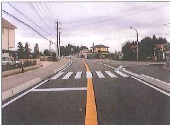
平21 道路改良工事 121号その1
