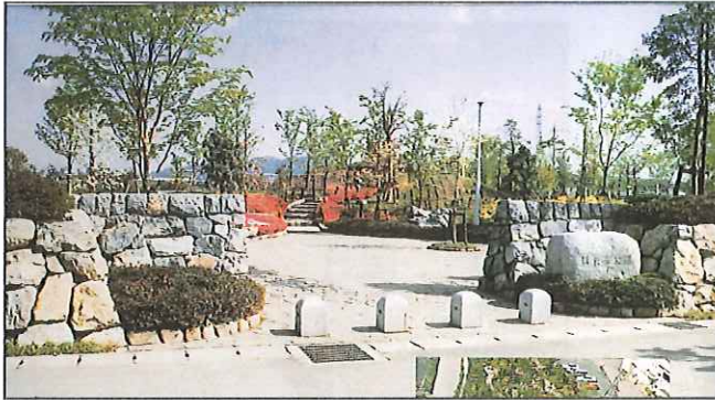
ほたる公園建設工事(鹿沼市)
