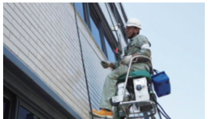
シーリング調査
