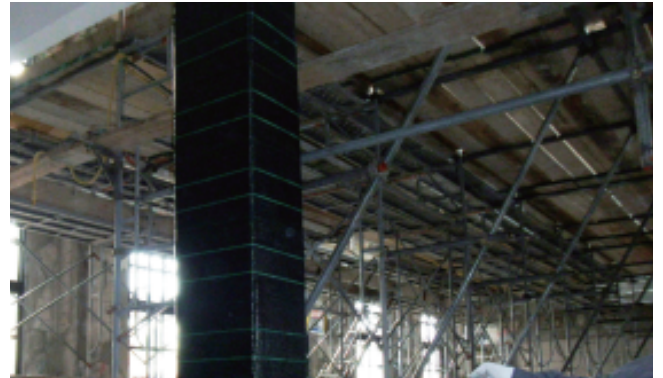
炭素繊維補強・柱
