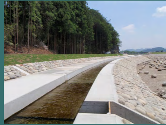
護岸工事 大芦川
