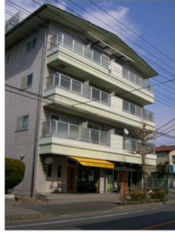
SSビル新築工事
