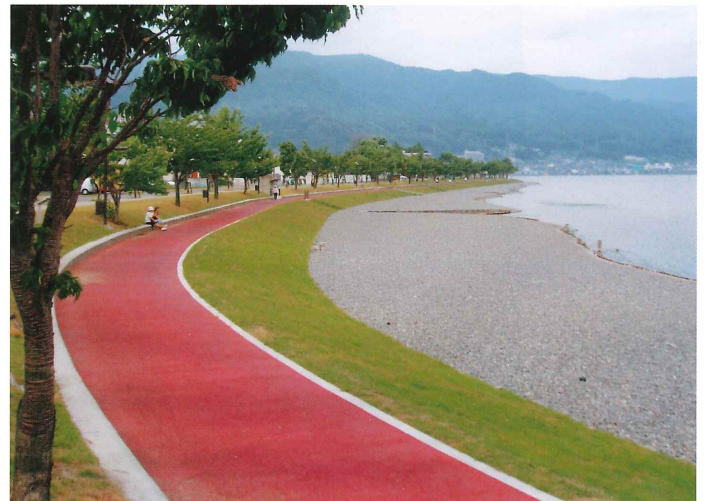
諏訪湖河川再生工事
