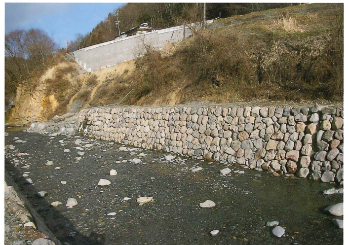
山の神河川護岸工事
