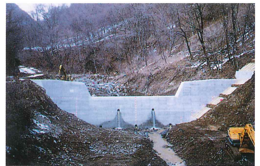
砥沢川堰堤工事
