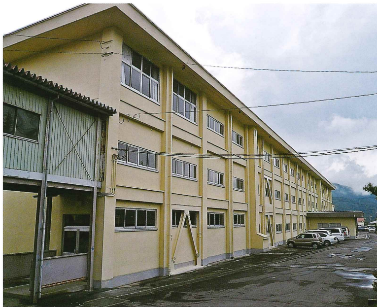
茅野高等学校耐震補強工事
