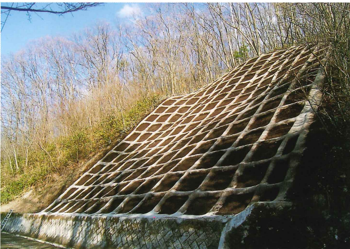
林道萩倉線改良工事(法面保護)
