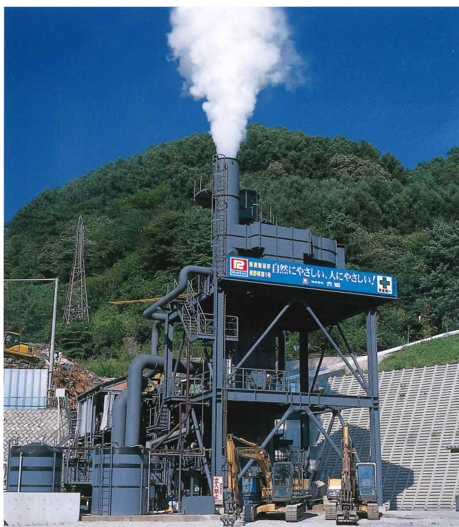
リサイクルセンター焼却炉（廃棄物処理法完全対応焼却炉） コンクリート破砕、再生路盤材の生産、木くず・廃プラ・紙くず・繊維くず・ゴムくずの焼却、最終処理
