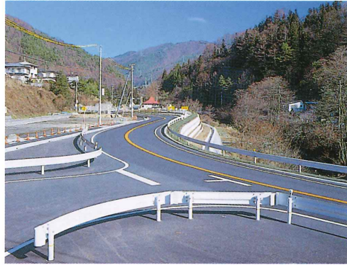
R142道路改良工事
