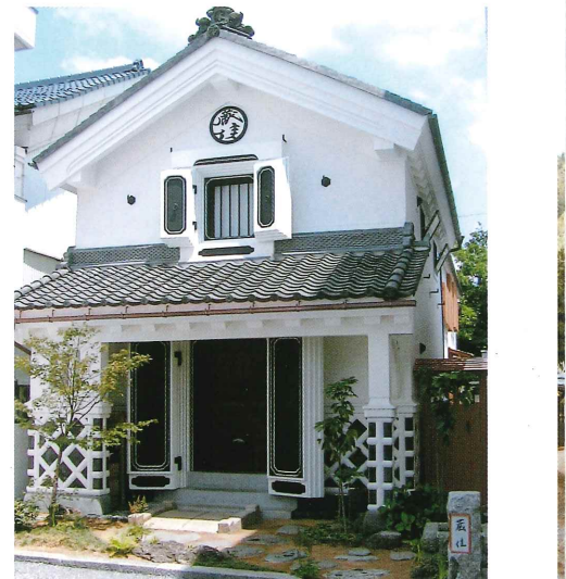
土蔵改修(松本市)
