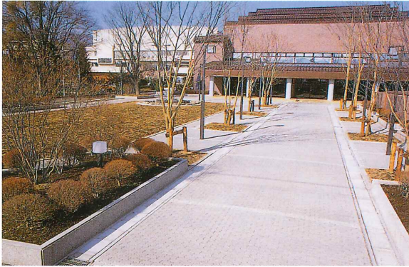
下諏訪町文化センター外溝工事
