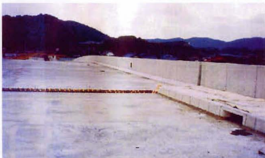
施主/国土交通省 工事名/埴生バイパス前場川橋床版他工事 ●場所/山口県山陽町
