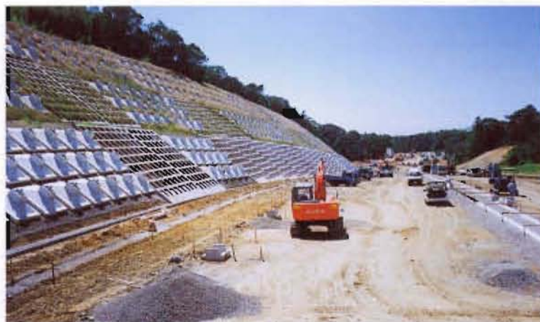
施主 / 山口県 工事名 / 一般国道490号線道路改良工事 ●場所 / 山口県宇部市
