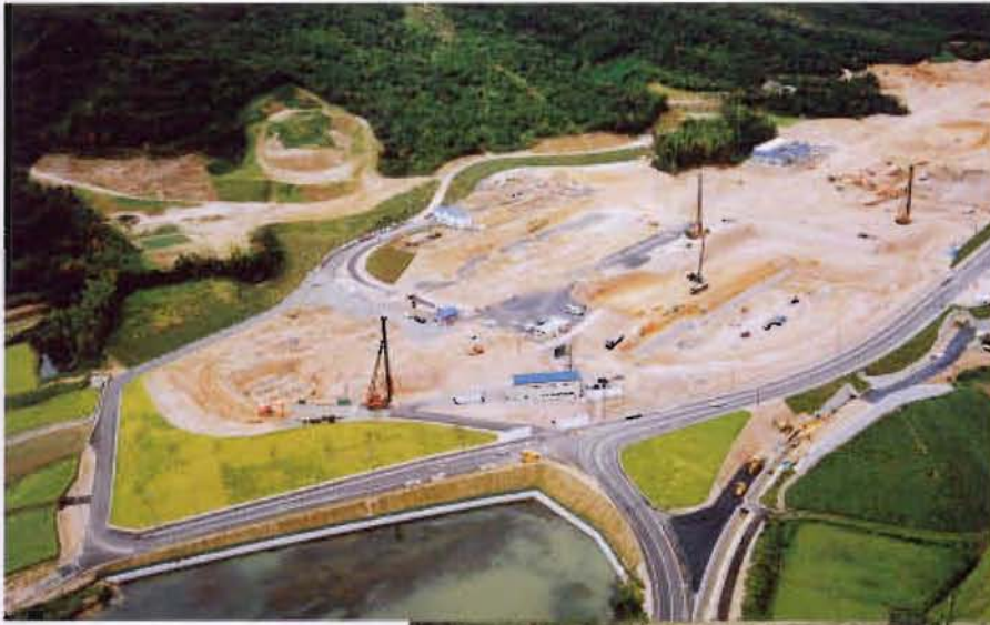
施主／山口県 工事名／セミナーパーク用地造成工事 ●場所／山口県山口市
