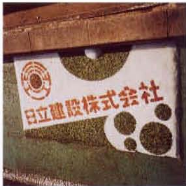
デザイン入り舗装 (日立建設(株)構内)
