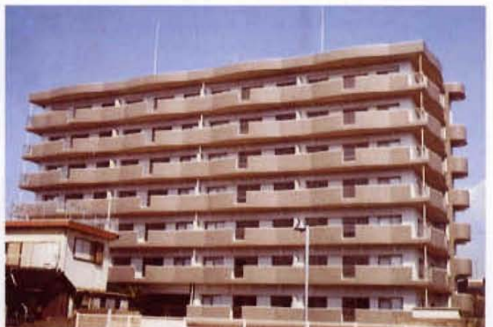
施主／山口エンジニアリング(株) 工事名／岬マンション新築工事 ●場所／山口県宇部市
