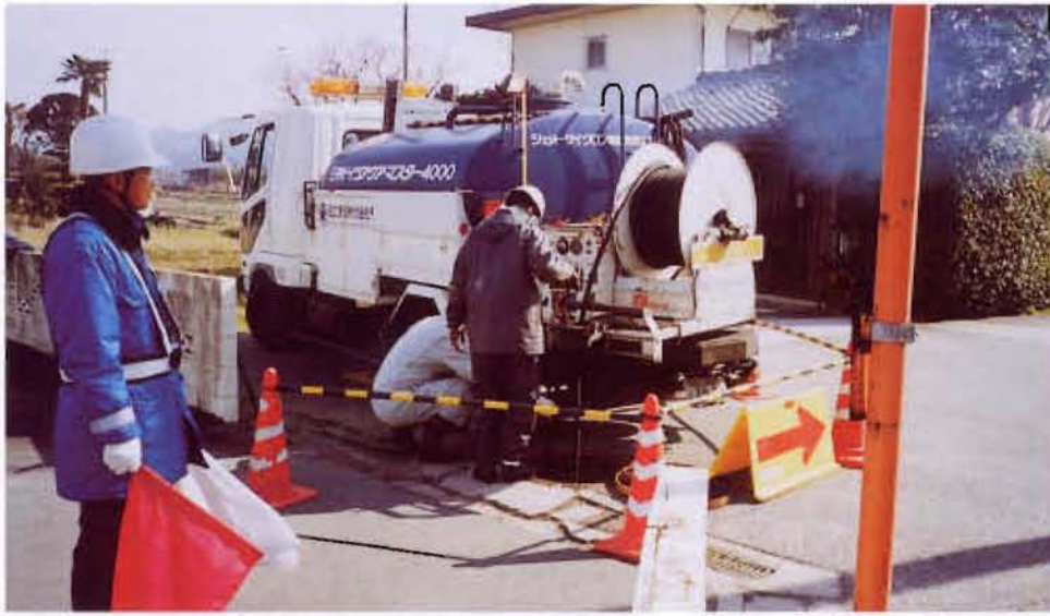
下水道管渠清掃
