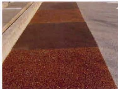
樹脂舗装 (日立建設(株)構内)
