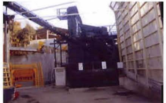
宇部瀝青工場クラッシングプラント 製造能力/25~40T/H 型 式/TCP-30
