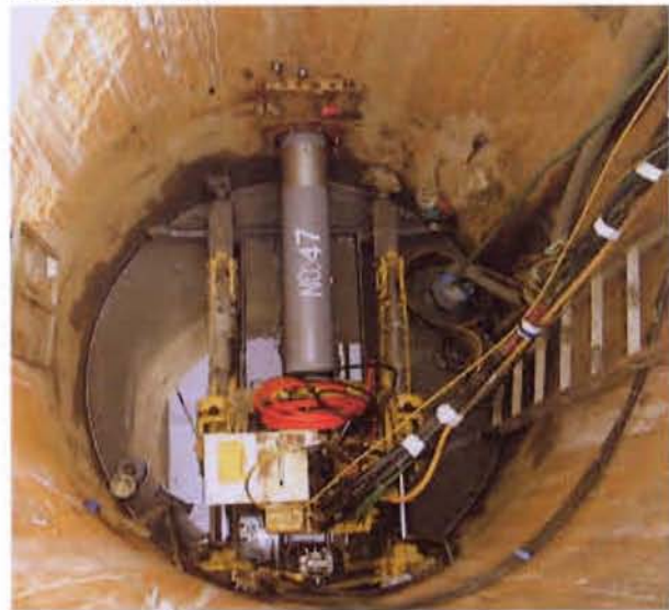
エンパイナ工法
