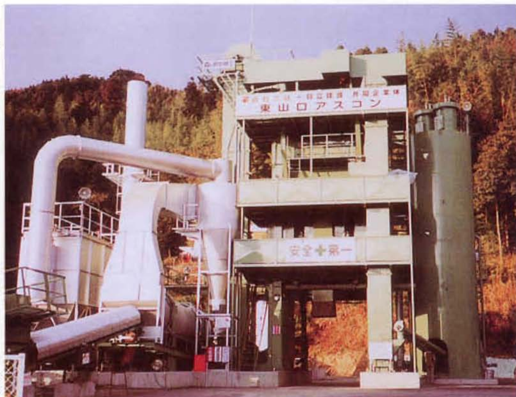
東山口アスコン (鹿島道路・日立建設JV) 製造能力/60T/H (1.5T/1バッチ) 型 式/TAP-1015E-LB
