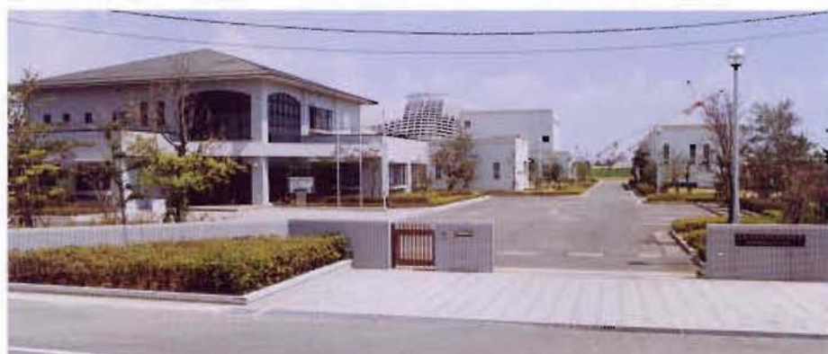
施主／日本下水道事業団 工事名／阿知須浄化センター建設工事 ●場所／山口県阿知須町
