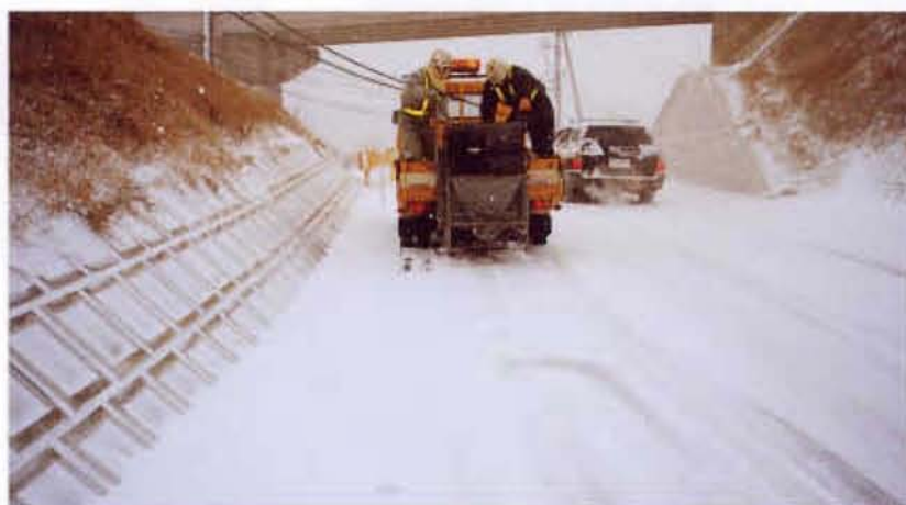
施主/山口県 工事名/山口宇部有料道路 保守点検業務 ●場所/山口県宇部市
