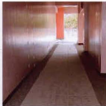
フロア舗装 (宇部市環境保全センター)
