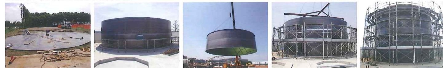
①底板加工
