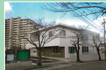
H27 香住丘公民館・老人いこいの家 複合施設改築工事
