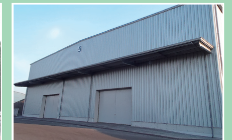
H23響ヤード5号倉庫新築工事
