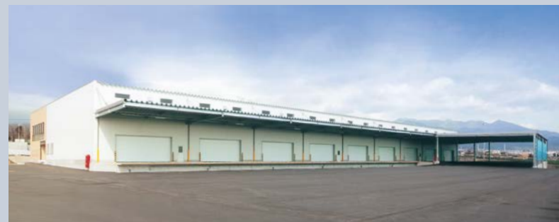
タカキュー物流倉庫・富士市
