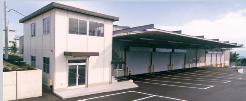
日本プラスト運輸山宮倉庫・富士宮市
