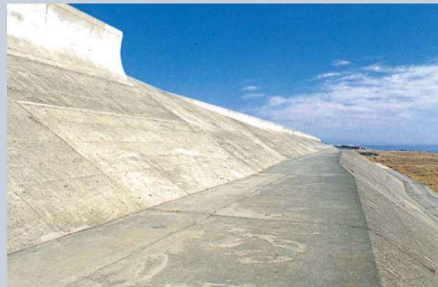
国土交通省・富士海岸富士地区堤防その1・富士市
