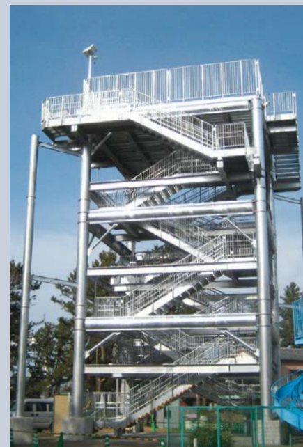
富士市立浜幼稚園津波避難タワー・富士市
