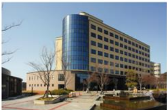
和歌山大学 学部棟【新築工事】/他社共同事業
