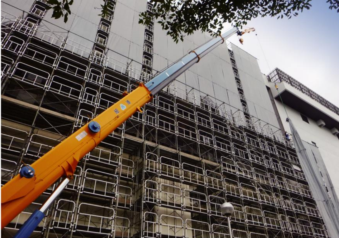
青岸エネルギーセンター【基幹改良工事の内土水・建築工事】
