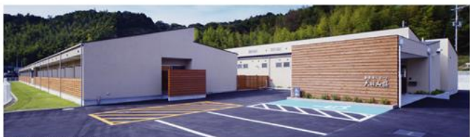
介護老人ホーム大日山荘【新築工事】
