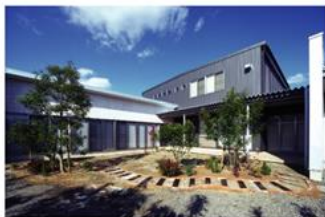
ミル・フェルム(有限会社シーエスピー)【新築工事】
