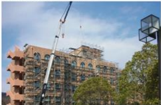
近畿大学 生物理工学部1号館-新1号館【外壁改修工事】
