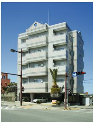
ラクスパーマンション【新築工事】
