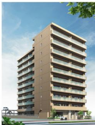
泉南マンション【新築工事】(施工中)
