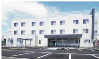
TSサービス付高齢者向け住宅【新築工事】
