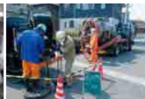
東日本大震災復旧工事
