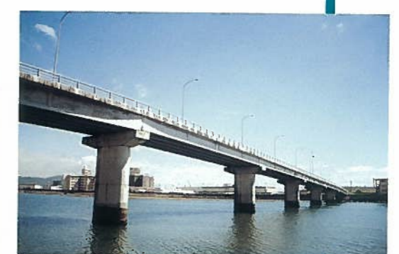
岩国飛行場内架橋上下部工事
