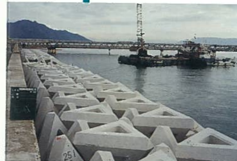
海岸防潮工事
