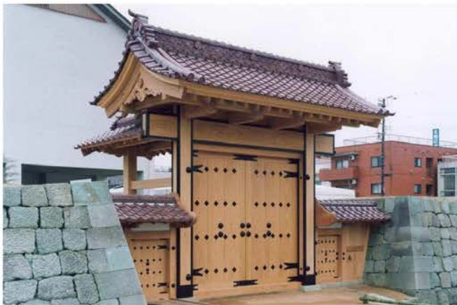
舎人門 復元工事
