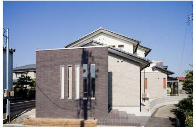
I邸 新築工事
