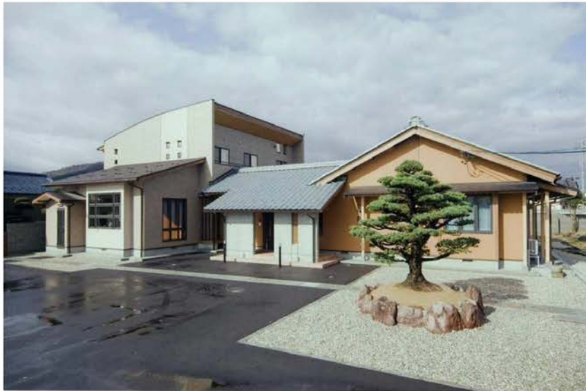
A邸 新築工事
