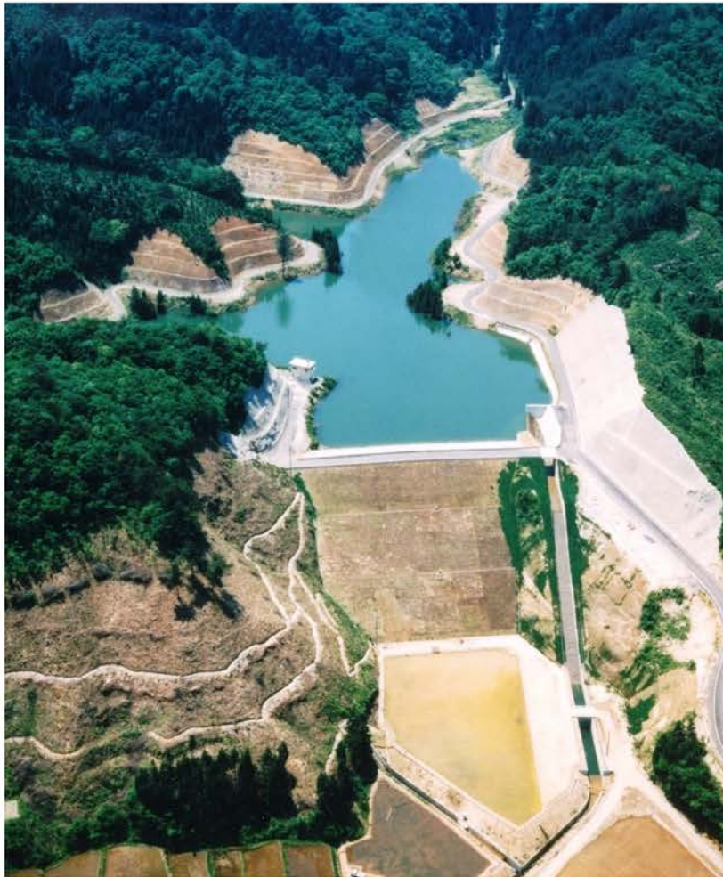
総ヶ谷ダム工事
