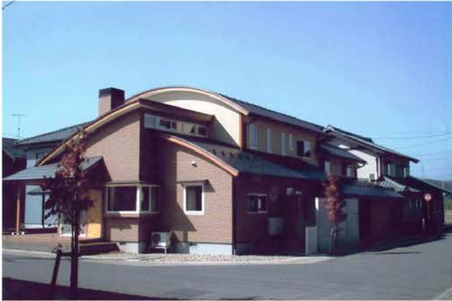
F邸 新築工事
