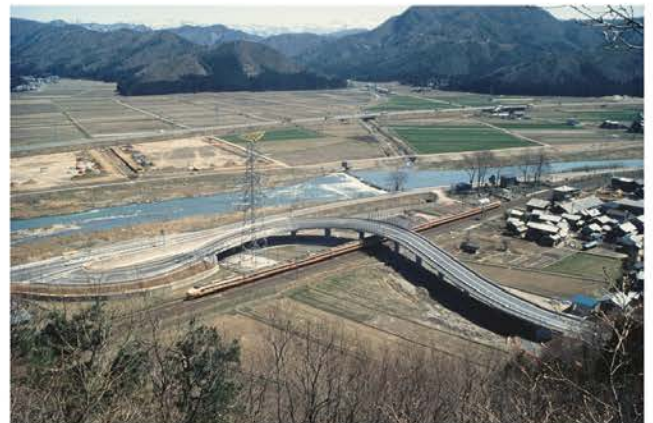
踏切除却事業
