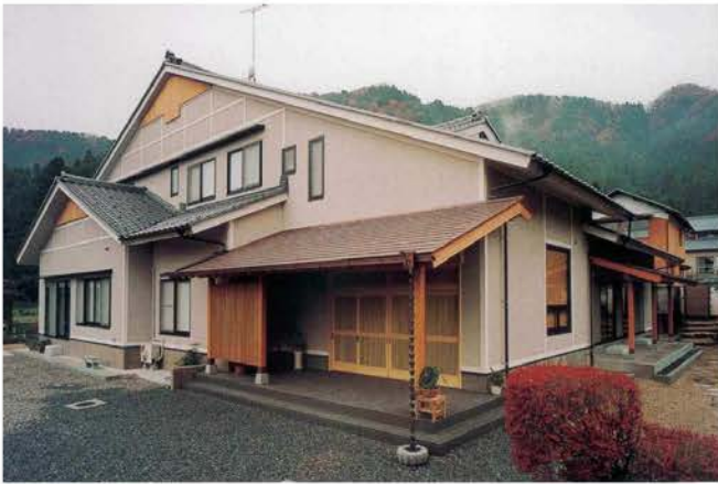
H邸 新築工事
