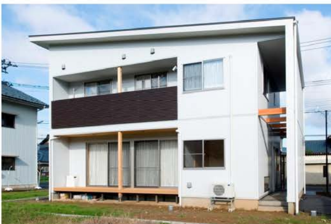
J邸 新築工事
