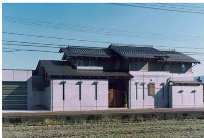
D邸 新築工事
