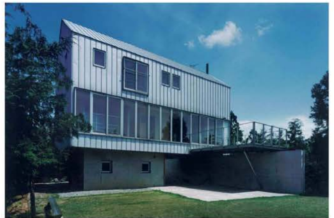
C邸 新築工事
