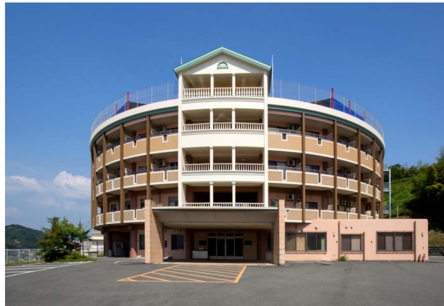
老健施設 3・4・5階増築工事
