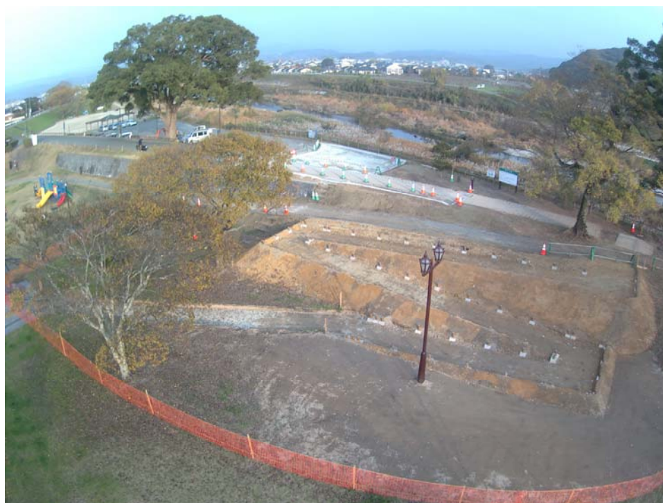
施工中：公園内バリアフリー通路・駐車場整備工事
