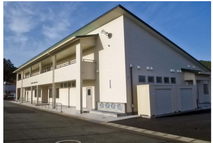
スポーツ公園クラブハウス建築工事
