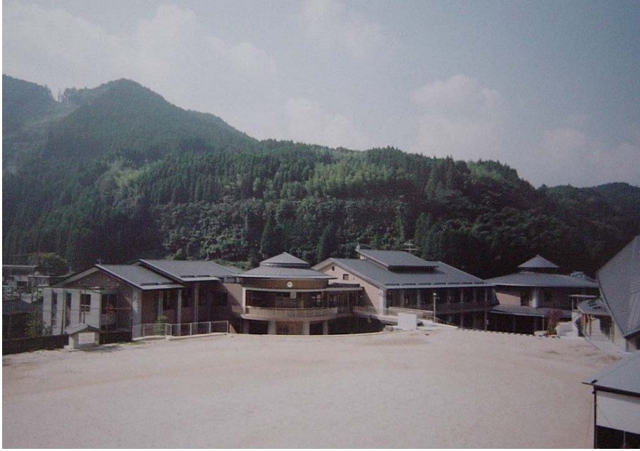
中学校校舎新築工事
