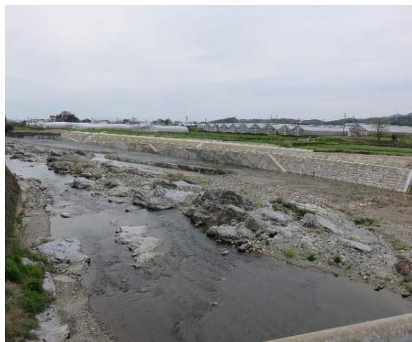
星野川筋河川改良復旧工事
