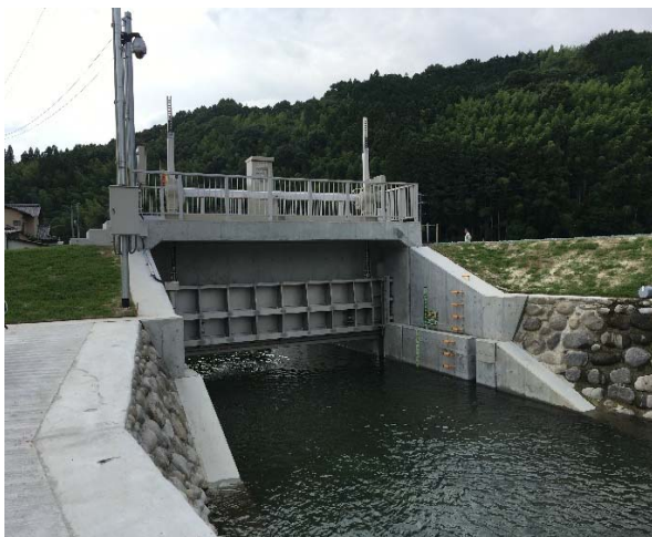
星野川筋山ノ井川水門本体工事
