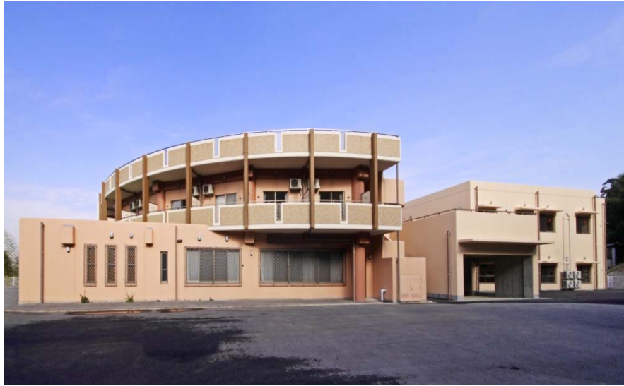
老健施設 10床及びショートステイ居室10床増築工事
