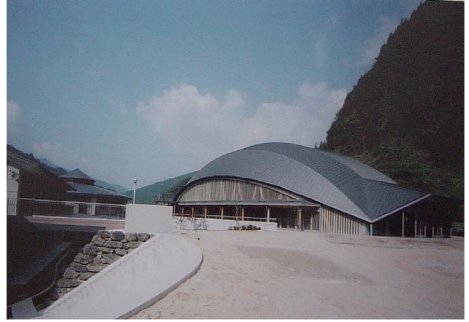
多目的交流ホール新築工事
