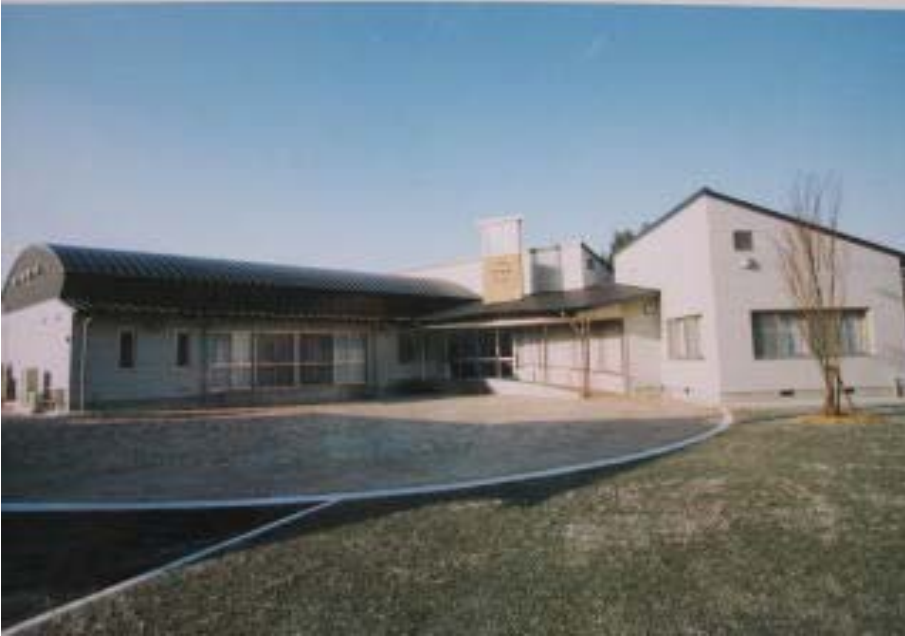
公民館新築工事
