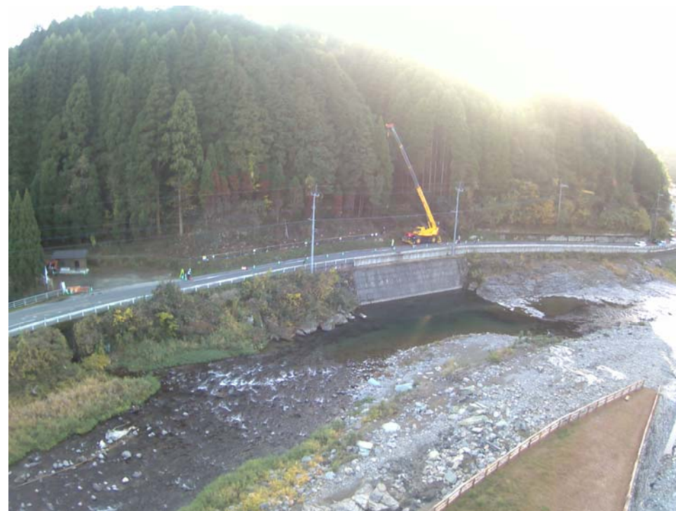
県道仮設防護柵工事（1工区）
